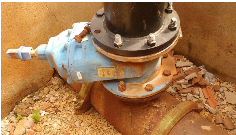
Figura 15 – Parafusos que fixam a válvula de gaveta da adutora, localizada no início da cidade de Pau dos Ferros-RN, Bairro João XXIII (23)
