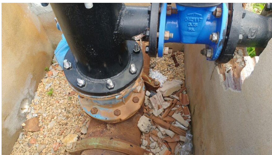
Figura 13 – Parafusos de fixação, localizada no início da cidade de Pau dos Ferros-RN, Bairro João XXIII (23)
