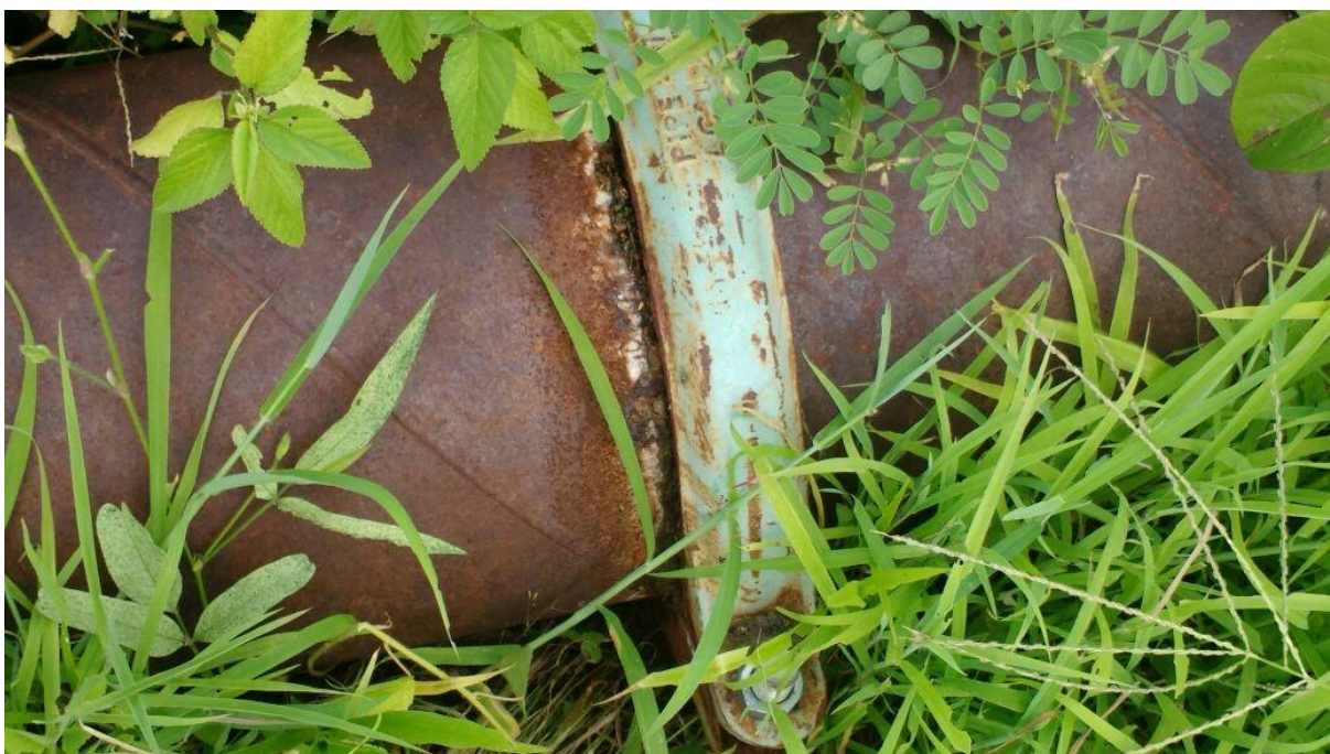
Figura 10 – Parte da tubulação da adutora, localizada no início da cidade de Pau dos Ferros-RN, Bairro João XXIII (23)
