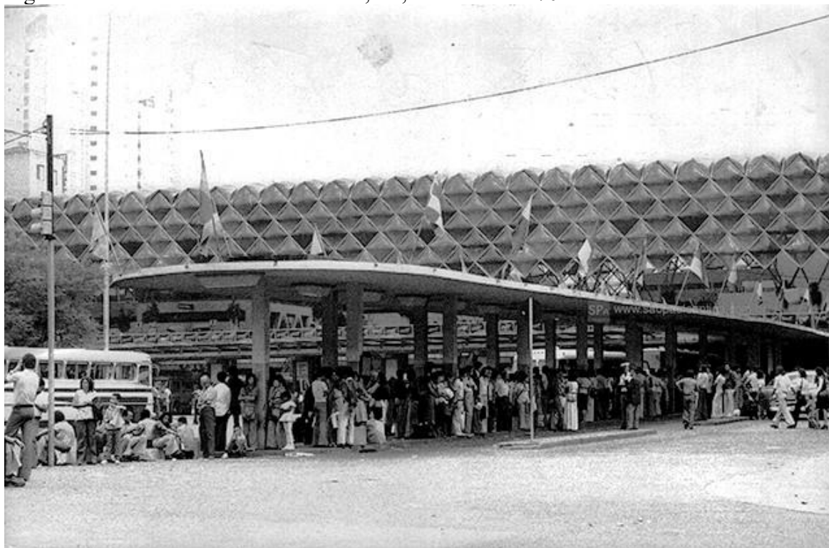
Figura 2 – Terminal Rodoviário da Luz, SP, na década de 70
