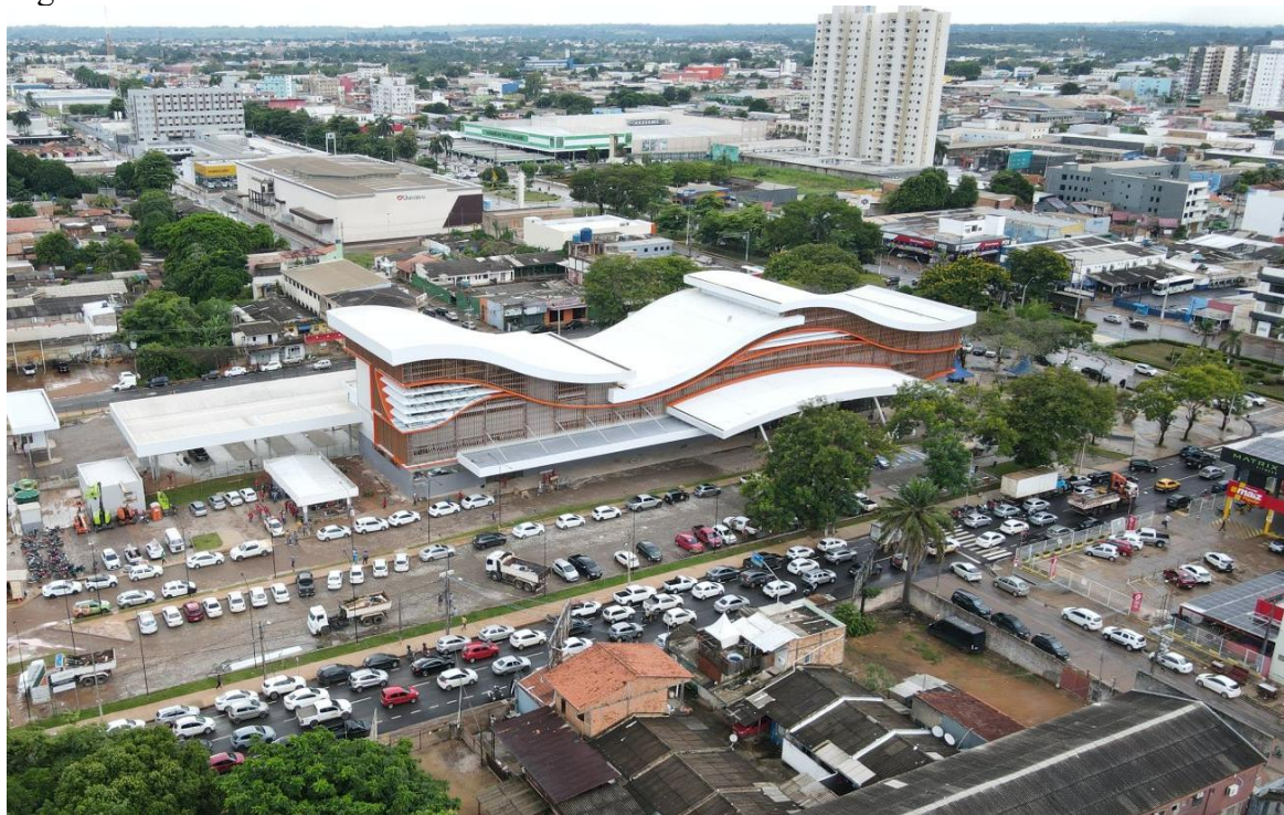
Figura 28 – Vista aérea do Terminal Rodoviário de Porto Velho
