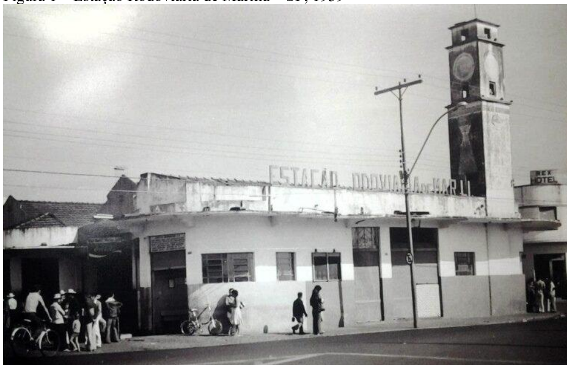
Figura 1 – Estação Rodoviária de Marília – SP, 1939
