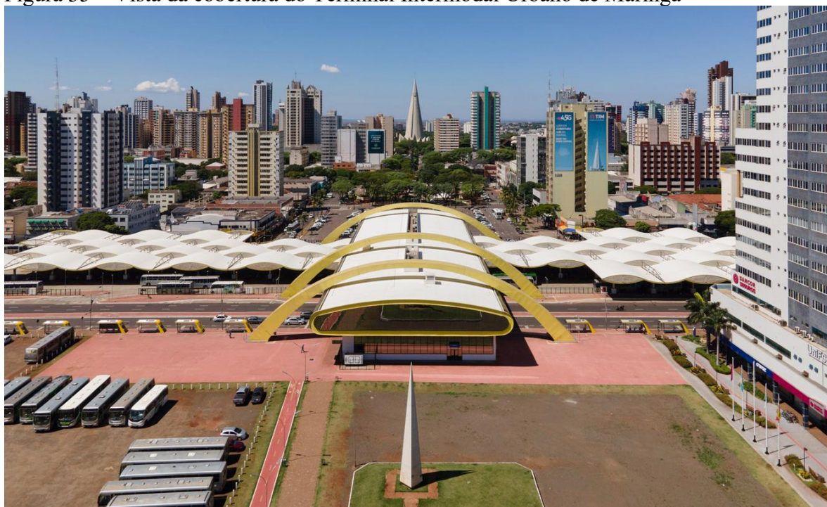
Figura 35 – Vista da cobertura do Terminal Intermodal Urbano de Maringá
