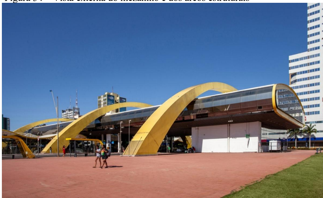
Figura 34 – Vista externa do mezanino e dos arcos estruturais
