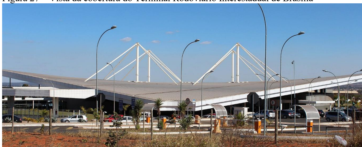
Figura 27 – Vista da cobertura do Terminal Rodoviário Interestadual de Brasília
