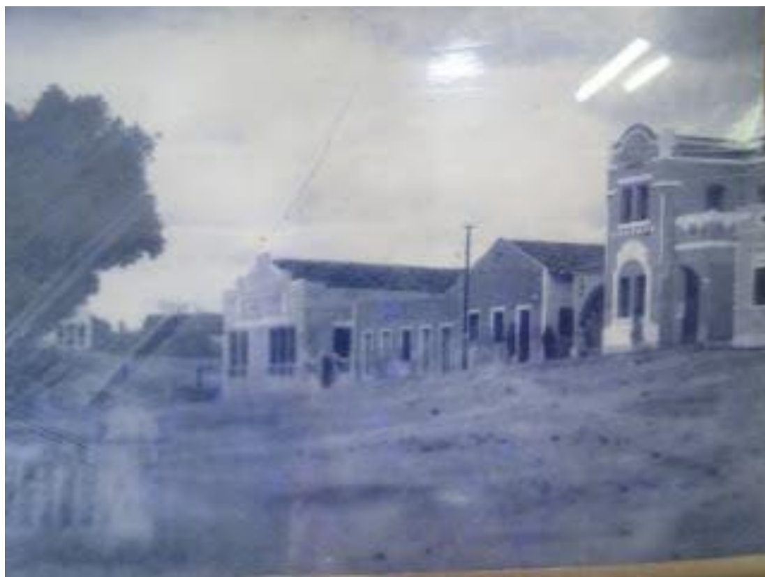
Figura 8 – Casa Paroquial e edificações residenciais ao entorno da Capela.
