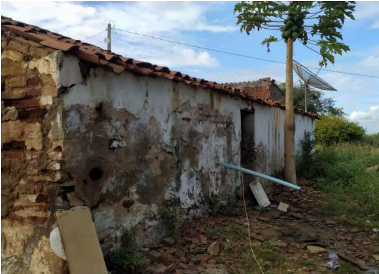
Figura 20: Paredes identificadas em tijolo comum. Fonte: Autoria própria, 2025.
