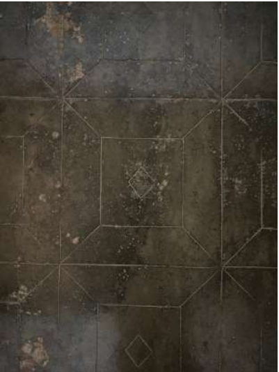
Figura 109: Piso de cimento queimado. Fonte: Aatoria própria, 2025.
