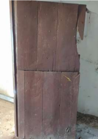
Figura 06: Esquadrias originais feitas da madeira do cajueiro. Fonte: Autoria própria, 2025
