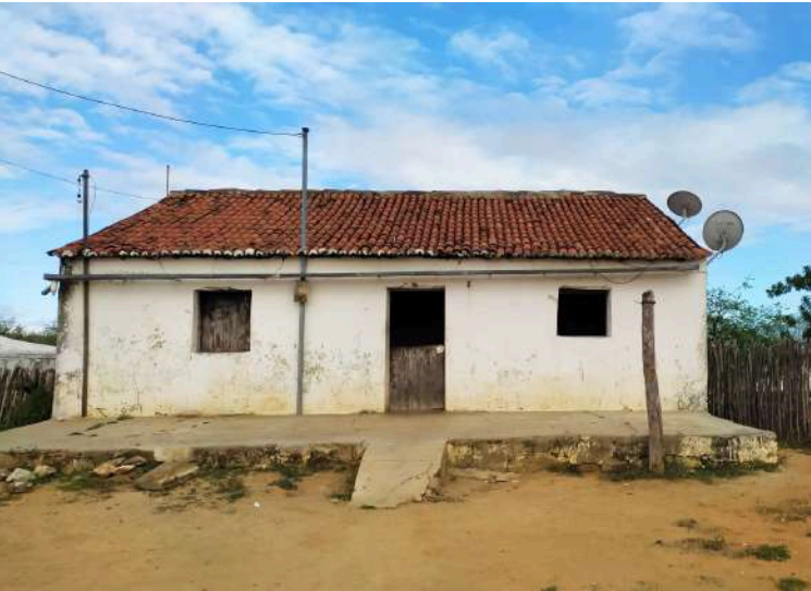
Figura 19: Cobertura substituída; portas externas substituídas. Fonte: Autoria própria, 2025.
