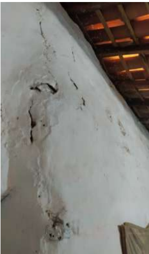
Figura 62: Paredes irregulares da taipa de mão. Fonte: Autoria própria, 2025.
