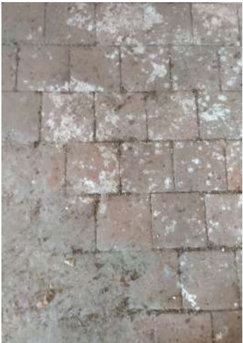
Figura 05: Piso em ladrilho de barro quadrado. Fonte: Autoria própria, 2025
