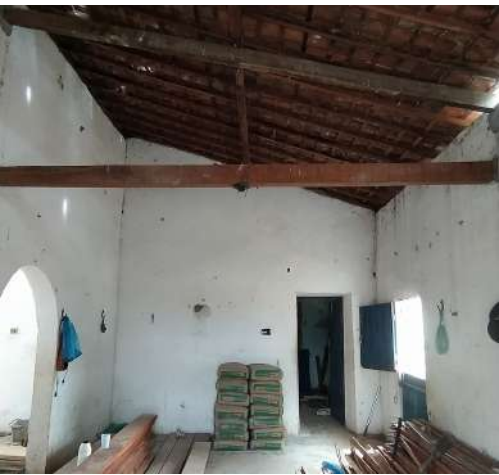
Figura 91: Sala de entrada. Tornos de rede; uma linha que antes poderia ser um brabo no lugar. Fonte: Autoria própria, 2025.
