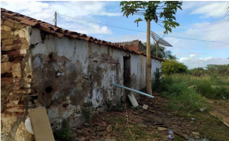
Figura 24: Vista lateral. Elementos: altura da parede e da janela. Fonte: Autoria própria, 2025.
