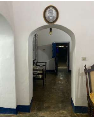
Figura 111: Vista da segunda sala para a primeira. Elementos: vãos em arco; cimento queimado no piso e rodapé com pintura azul. Fonte: Autoria própria, 2025.
