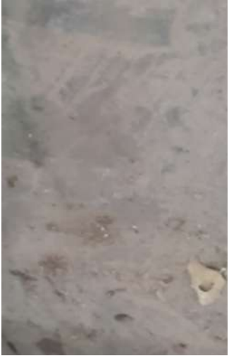
Figura 87: Piso de cimento queimado. Fonte: Autoria própria, 2025.
