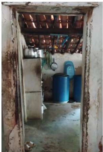
Figura 35: Esquadrias com vergas de madeira. Fonte: Autoria própria, 2025.
