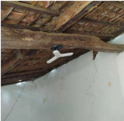
Figura 26: Telhado. Fonte: Autoria própria, 2025.
