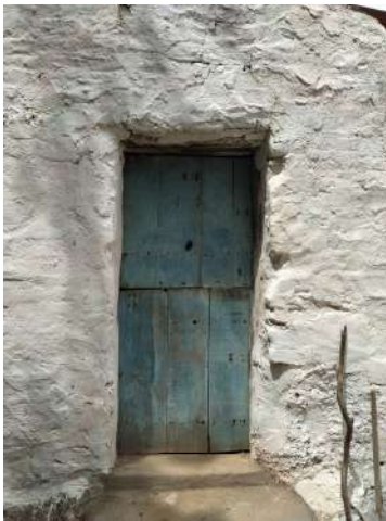
Figura 77: Porta de madeira umburana. Fonte: Autoria própria, 2025.
