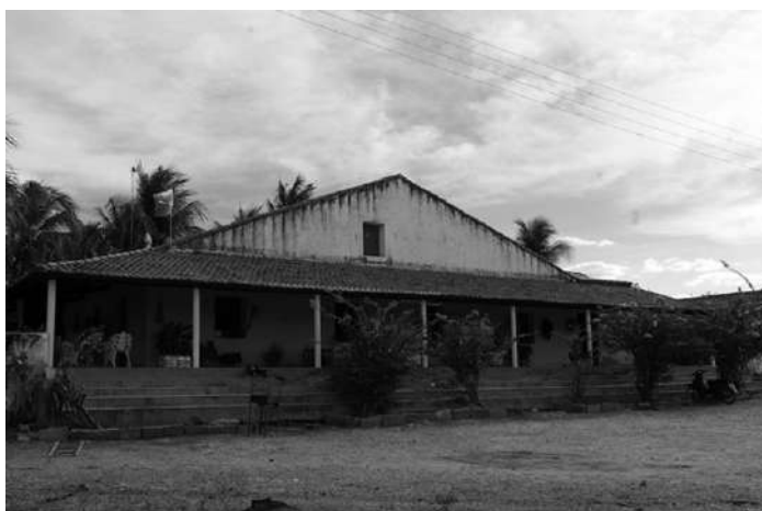
Figura 4 - Fachada e alpendre em 2008
