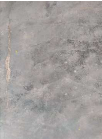
Figura 39: Piso de cimento queimado. Fonte: Autoria própria, 2025.
