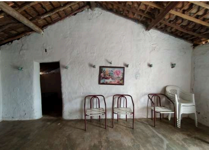
Figura 60: Cobertura, paredes de taipa de mão e piso de cimento queimado. Fonte: Autoria própria, 2025.
