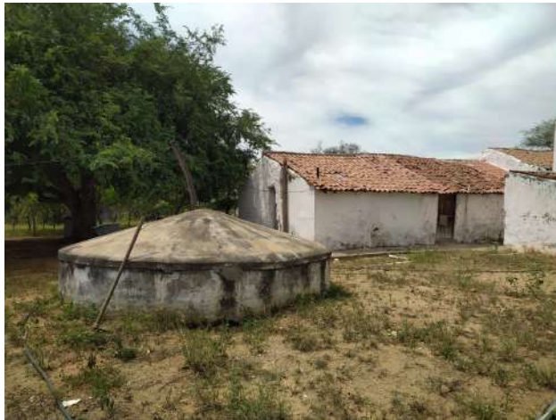
Figura 67: Vista lateral em perspectiva. Elementos: Banheiro externo na lateral; ccontraste de telhas cerâmicas novas e antigas; Altura das esquadrias. Fonte: Autoria própria, 2025.
