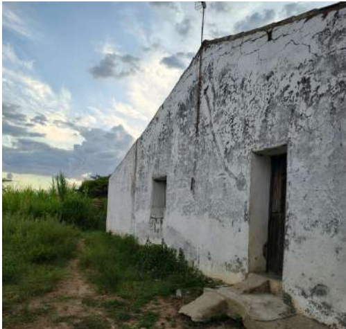
Figura 90: Vista lateral. Altura da cumeeira. Fonte: Autoria própria, 2025.
