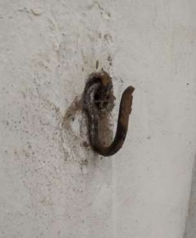
Figura 98: Torno de rede de ferro, podem ter substituído os de madeira. Fonte: Autoria própria, 2025.
