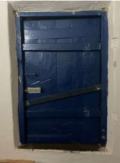
Figura 108: Janelas de uma folha e de giro. Fonte: Aatoria própria, 2025.
