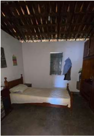
Figura 136: Quarto 01. Elementos: janela de giro. Fonte: Autoria própria, 2025
