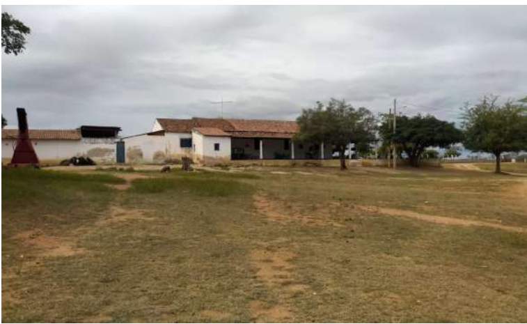
Figura 45: Vista lateral. Elementos: volume da casa. Fonte: Autoria própria, 2025.
