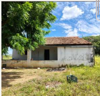
Antes da reforma de 2025. Fonte: Solange Jales, 2025.
