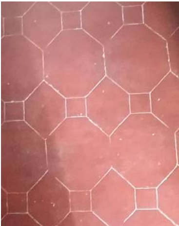
Figura 42: Piso na cor vermelha de cimento queimado carimbado. Fonte: Autoria própria, 2025.
