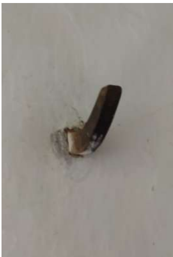
Figura 32: Armador de madeira. Fonte: Autoria própria, 2025.
