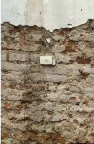
Figura 84: Paredes de tijolo comum. Fonte: Autoria própria, 2025.
