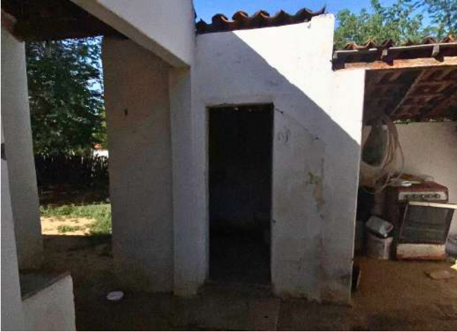
Figura 137: Banheiro externo de tijolo comum. Fonte: Autoria própria, 2025
