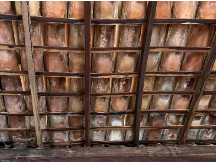
Figura 128: Telhado. Fonte: Autoria própria, 2025
