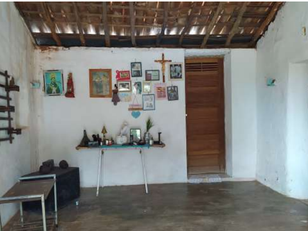
Figura 70: Sala de entrada. Fonte: Autoria própria, 2025.
