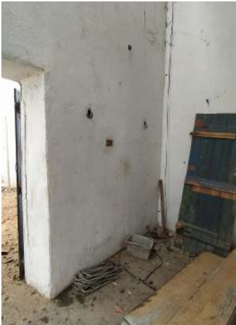
Figura 94: Sala de entrada. Fonte: Autoria própria, 2025.
