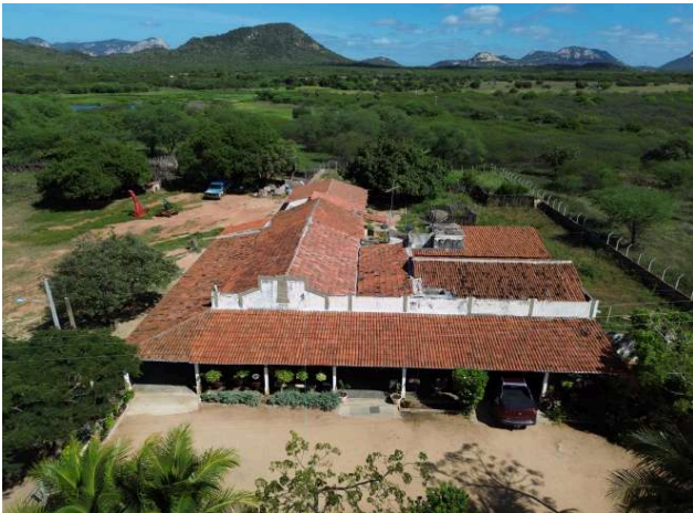
Figura 38: Platibanda existente. Fonte: Autoria própria, 2025.
