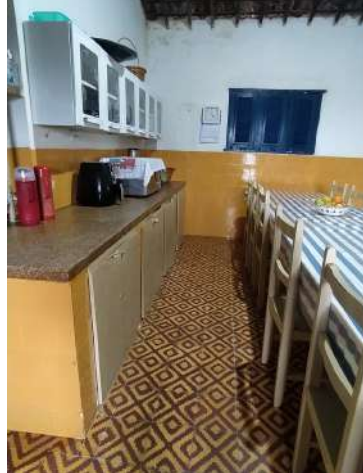
Figura 51: Cozinha. Elementos: azulejo; piso de ladrilho hidráulico; bancada de alvenaria de tijolo cerâmico. Fonte: Autoria própria, 2025.
