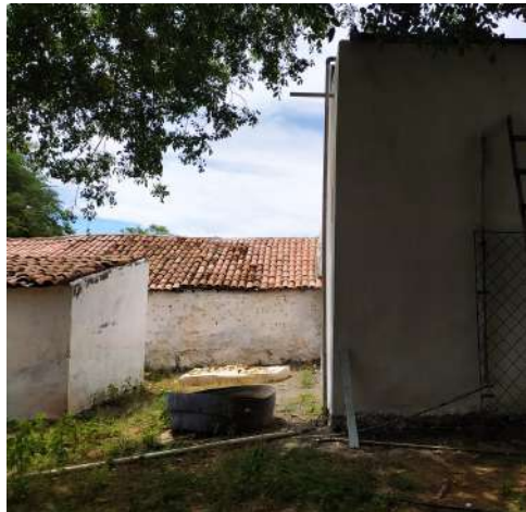
Figura 68: Vista posterior. Elementos: contraste do pé direito da casa com a parte adicionada em alvenaria. Fonte: Autoria própria, 2025.
