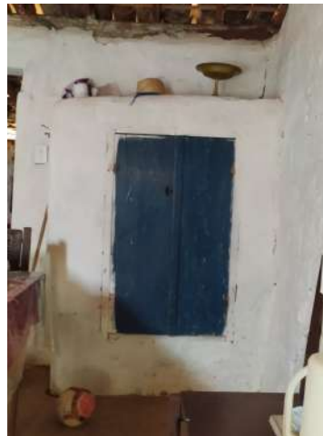
Figura 79: Armários de alvenaria. Fonte: Autoria própria, 2025.
