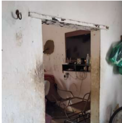
Figura 28: Sala de jantar. Elementos: Vergas de madeira; armadores de ferro. Fonte: Autoria própria, 2025.
