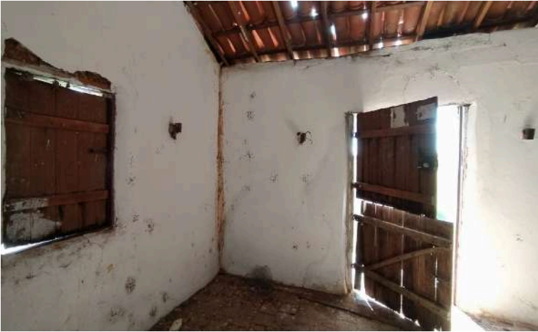
Figura 09: Sala de estar. Elementos: armadores de madeira; Telha modificada. Fonte: Autoria própria, 2025.
