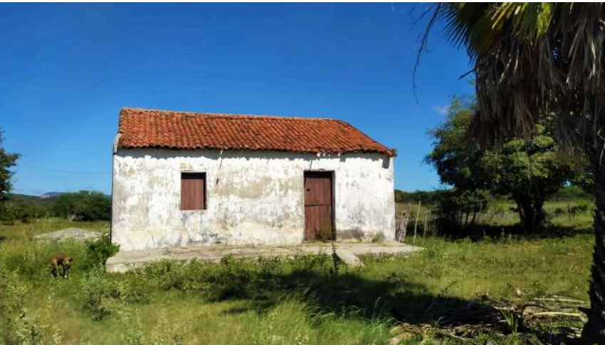
Figura 03: Cobertura nova, mas do mesmo material; paredes de tijolo comum; portas de cajueiro. Fonte: Joseane Medeiros, 2025.
