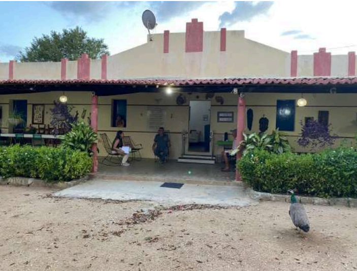
Figura 105: Vista forntal. Elementos: cobertura, quarto no alpendre, platibanda com alto relevo. Fonte: Aatoria própria, 2025.
