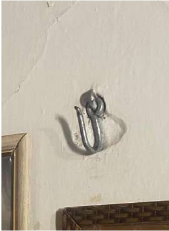
Figura 140: Torno de rede feito de ferro. Fonte: Autoria própria, 2025
