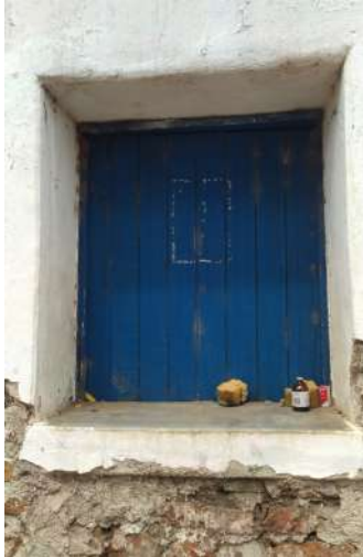
Figura 86: Janelas de uma folha e de giro. Fonte: Autoria própria, 2025.
