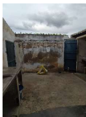
Figura 19 - Pátio próximo às áreas de serviço
