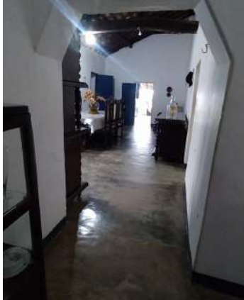
Figura 54: Aberturas com cantos de cima chanfrados. Fonte: Autoria própria, 2025.
