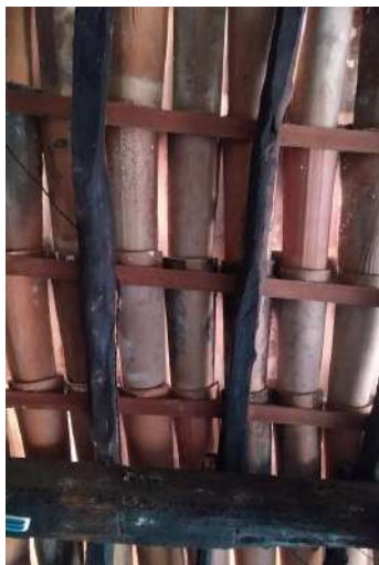
Figura 34: Caibros originais feitos de pereiro. Fonte: Autoria própria, 2025.
