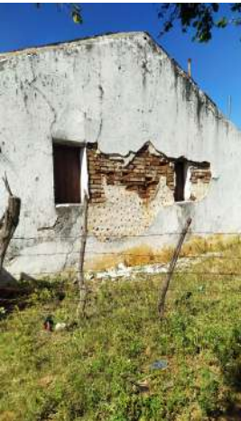
Figura 08: Vista lateral. Elementos: altura da cumeeira. Fonte: Autoria própria, 2025.
