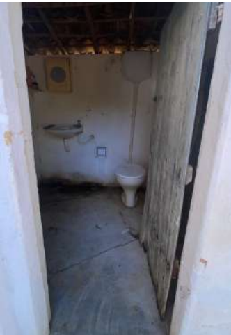
Figura 138: Vista interna banheiro. Fonte: Autoria própria, 2025
