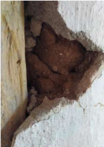
Figura 04: Paredes identificadas em tijolo comum. Fonte: Autoria própria, 2025
