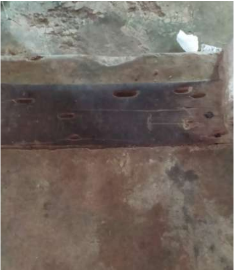
Figura 21: Piso cimento queimado. Elementos: soleira na abertura. Fonte: Autoria própria, 2025.
