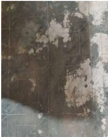
Figura 41: Piso de cimento queimado carimbado. Fonte: Autoria própria, 2025.
