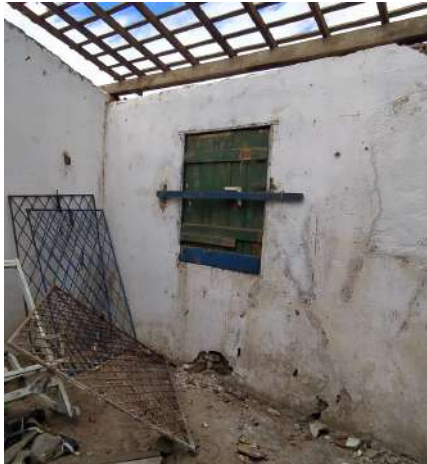
Figura 96: Quarto com entrada na segunda sala. Fonte: Autoria própria, 2025.
