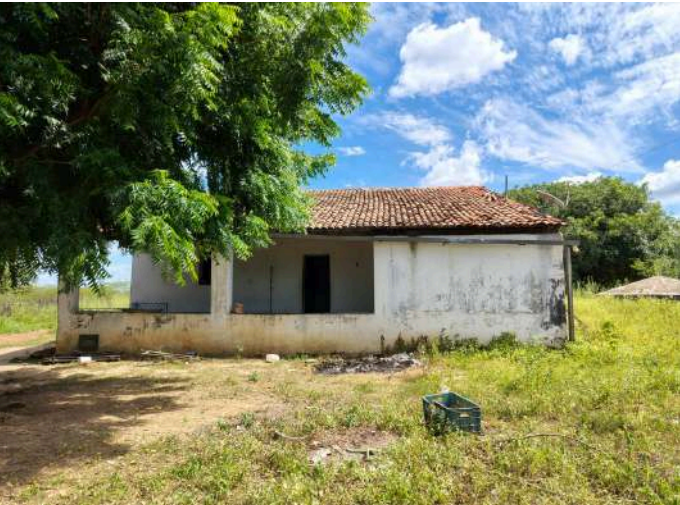
Figura 83: Imagem de antes da reforma. Elementos: cobertura, quarto no alpendre. Fonte: Autoria própria, 2025.
