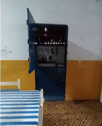
Figura 57: Portas de duas folhas sobrepostas; azulejo amarelo; piso de ladrilho hidráulico. Fonte: Autoria própria, 2025.
