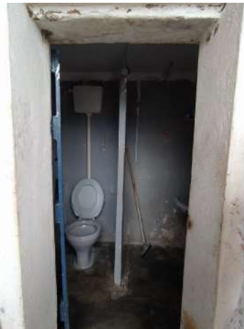
Figura 48: Primeiro banheiro feito na parte externa. Fonte: Autoria própria, 2025.
