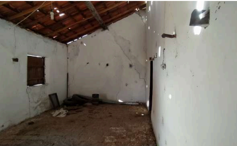
Figura 10: Sala de estar. Elementos: armadores de madeira. Fonte: Autoria própria, 2025.
