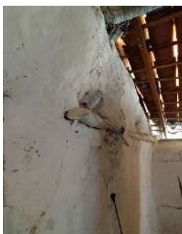
Figura 25 - Torno em parede de taipa
