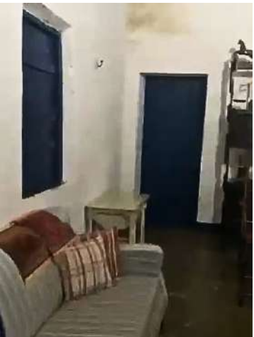
Figura 114: Sala de entrada. Tornos de rede. Fonte: Autoria própria, 2025.
