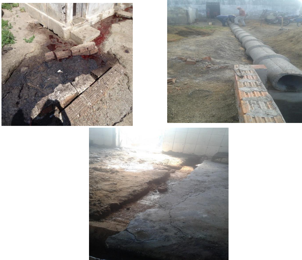
Figura 10: Construção de nova rede de esgotos de um abatedouro municipal do Rio Grande do Norte, Brasil, 2017.
