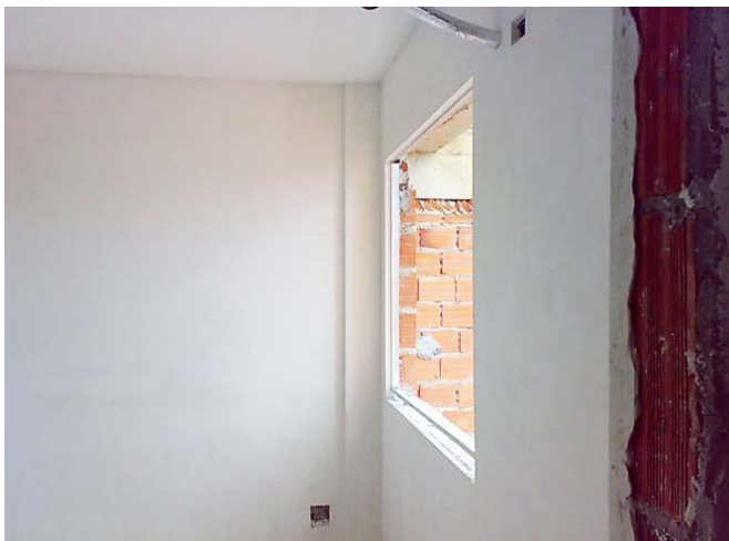
Figura 06 – Acabamento da pasta de gesso
