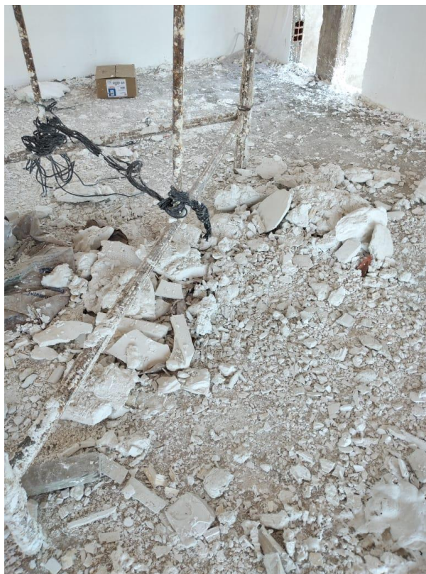
Figura 15 – Resíduos gerados na execução do revestimento de gesso na obra B
