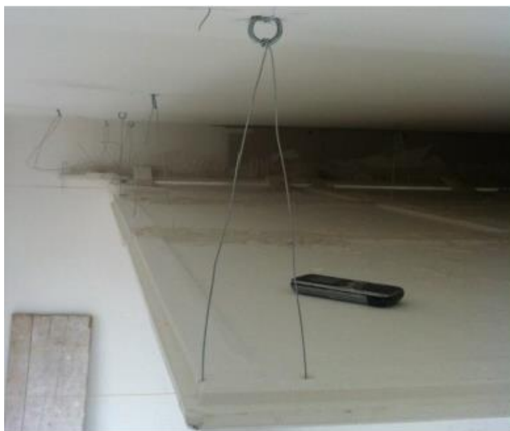
Figura 08 – Execução de forro de gesso
