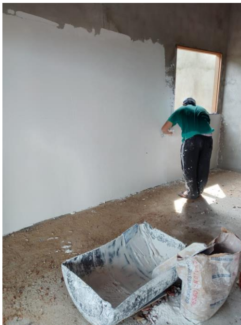
Figura 13 – Execução do revestimento de alvenarias internas na obra A
