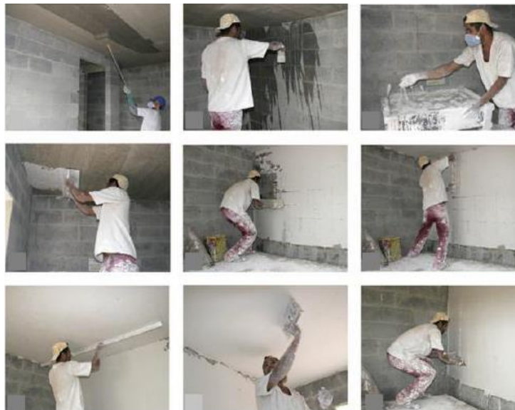
Figura 07 – Etapas de aplicação de revestimento desempenado
