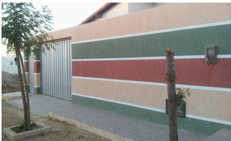
Figura 1 – Fachada das residências.
