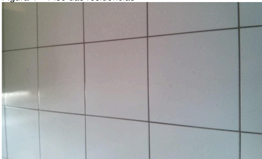
Figura 4 – Piso das residências
