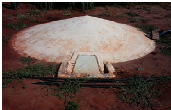
Figura 9 - Vista frontal do reservatório para armazenamento do excesso de esgoto doméstico tratado no sistema alagado construído.
