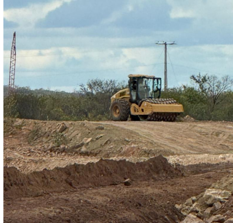
Figura 16 - Rolo compactador pé de carneiro vibratório
