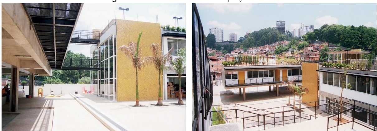
Figura 43 – Fachadas do edifício projeto viver.
