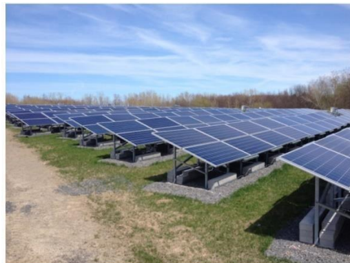
Figura 9 - Fixação de usinas solar no solo
