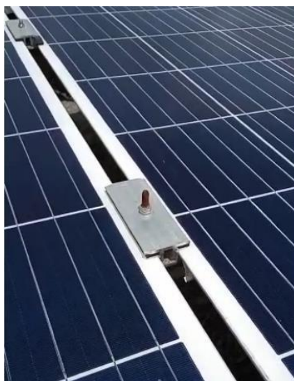
Figura 25 - Comparativo de um parafuso corroído e outro não (Usina da UFERSA)
