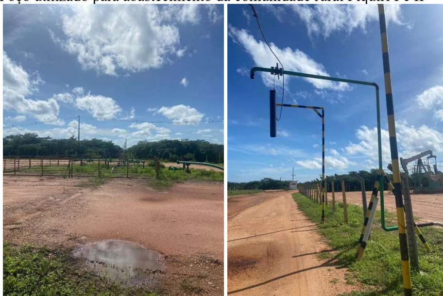
Figura 8 – Poço utilizado para abastecimento da comunidade rural Piquiri I e II
