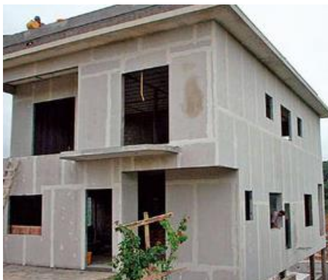
Figura 3. Edificação com utilização de placas cimentícias.
