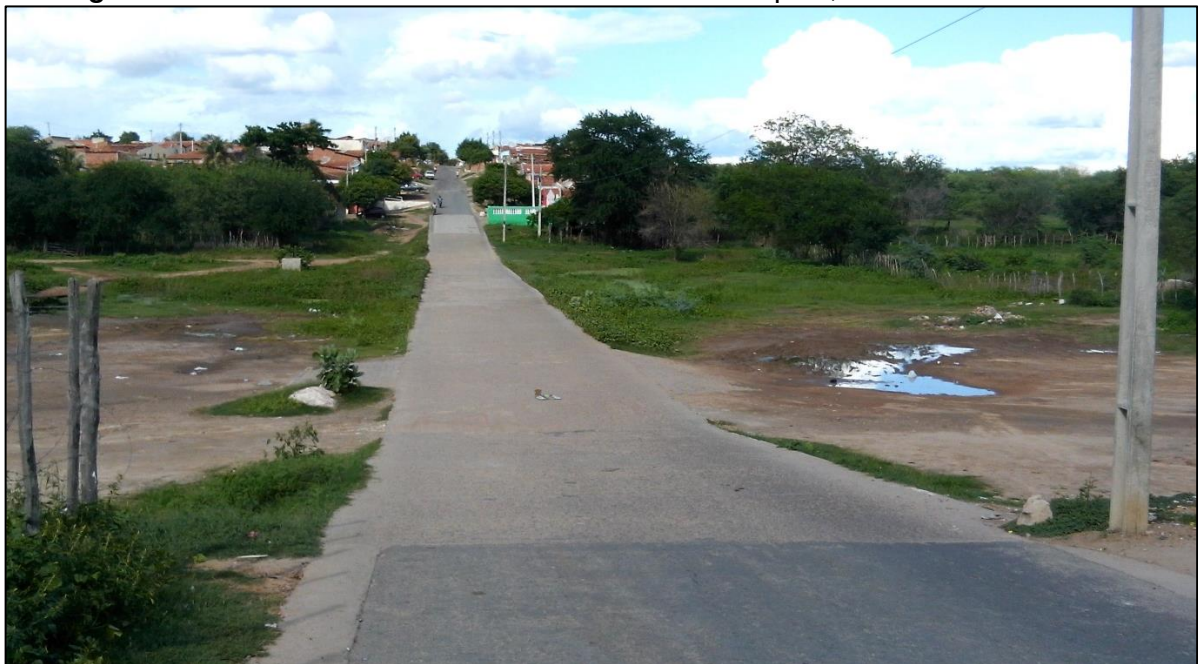
Figura 8: Passarela de concreto sobre o leito do Rio Apodi, localizada no trecho 1.
