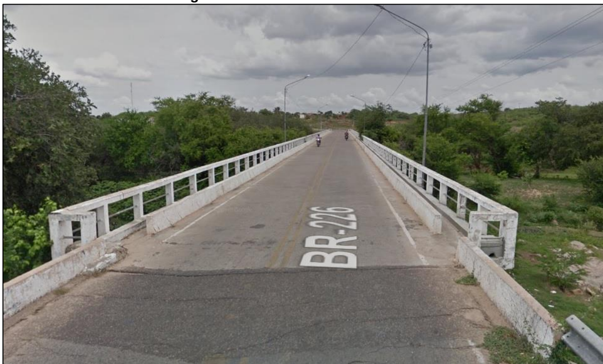
Figura 9: Ponte localizada no trecho 2.
