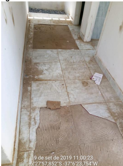
Figura 11 - Revestimento deteriorado.
