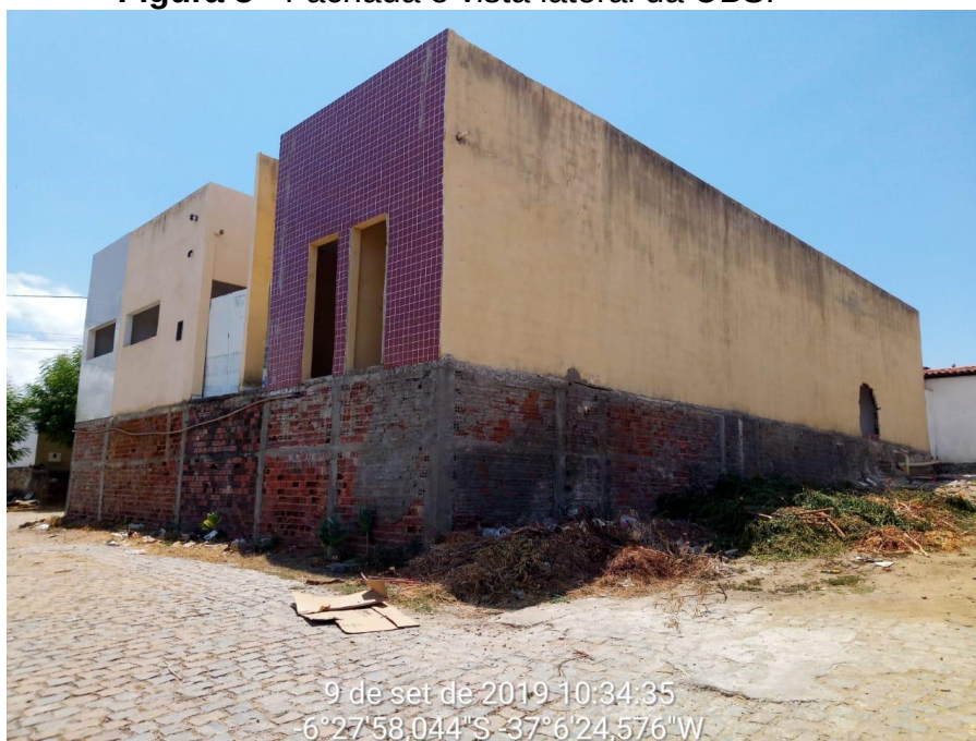
Figura 3 - Fachada e vista lateral da UBS.
