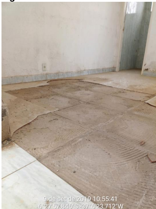
Figura 4 - Revestimento deteriorado.
