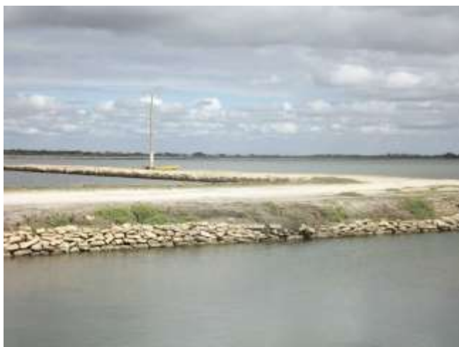
Figura 2: Evaporadores a céu aberto
