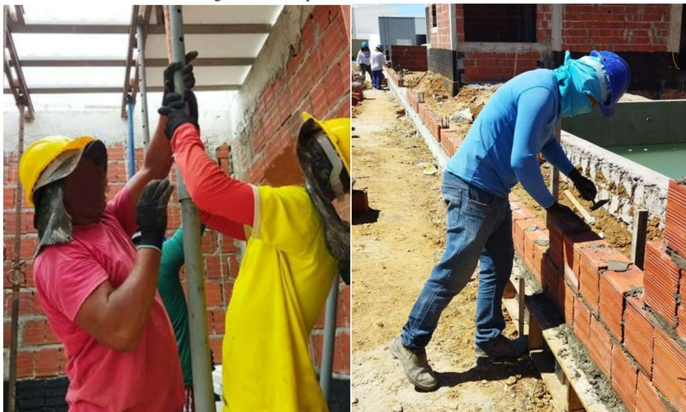
Figura 14 e 15: Operários trabalhando com uso de EPIs
