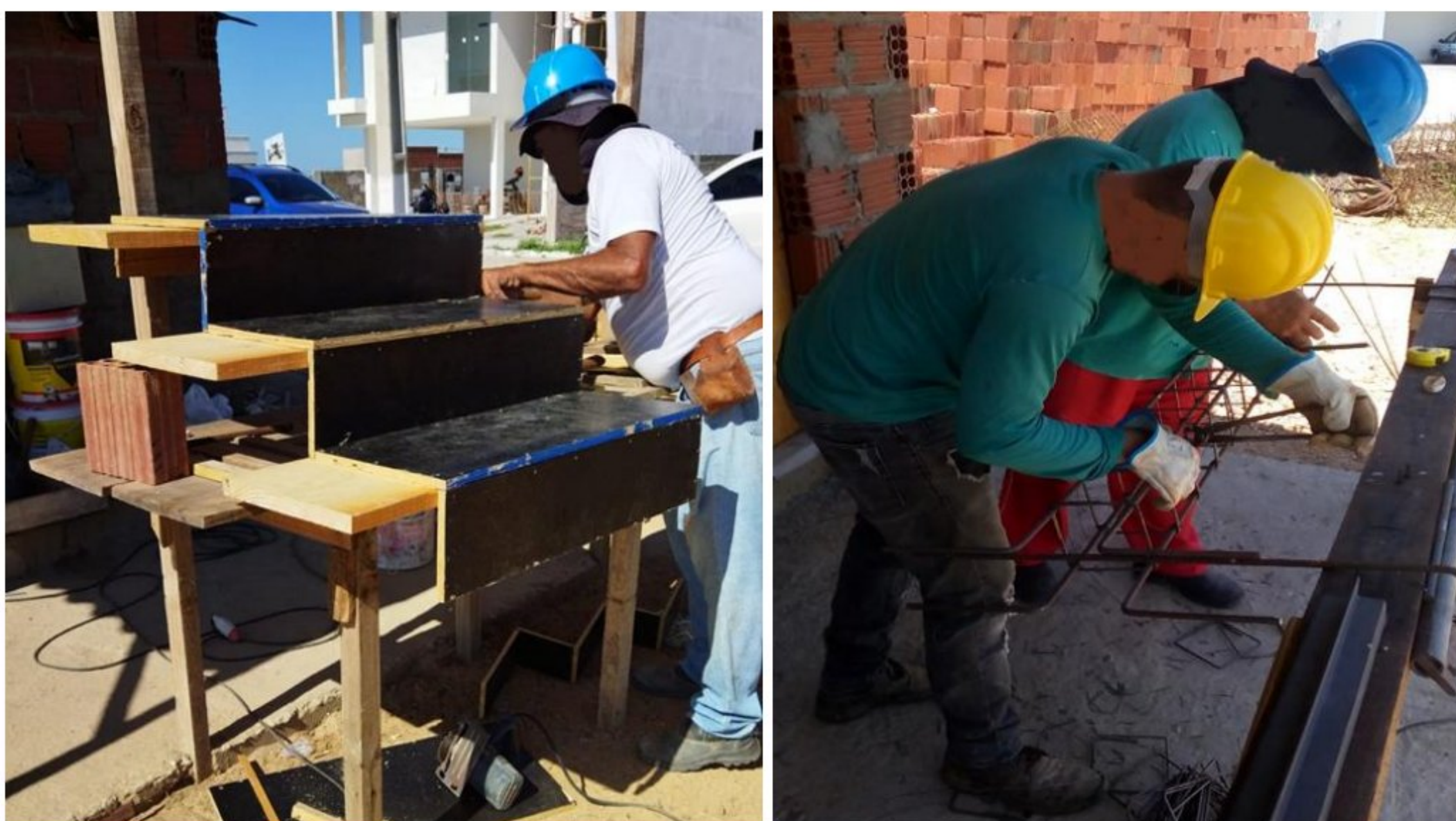
Figura 12 e 13 Central de carpintaria e aço
