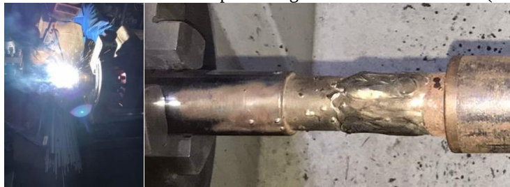
Figura 10 – Processo de enchimento do eixo por soldagem de eletrodo revestido (De autoria própria).
