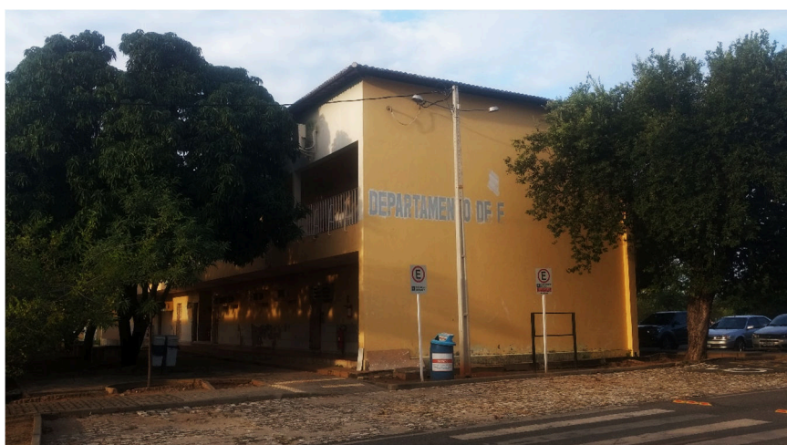
Figura 7 – Prédio das Engenharias, na UFERSA – Campus Mossoró
