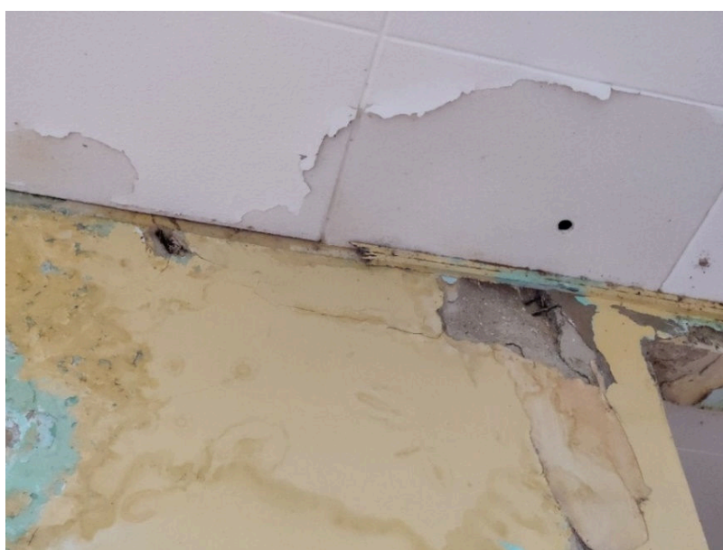
Figura 16 – Exposição de armadura de aço na viga Vp2
