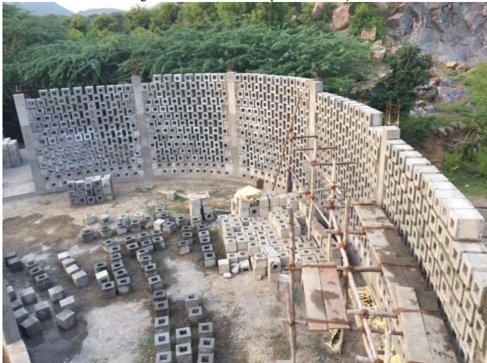
Figura 33 - Blocos usados para a construção
