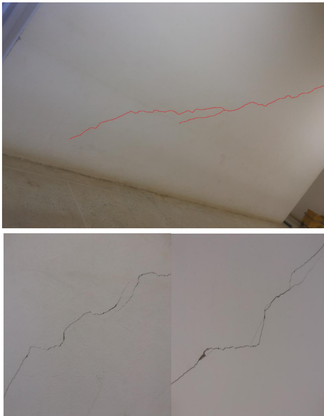
Figura 31 – Recalque diferencial.
