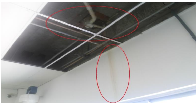
Figura 15 – Instalação Hidráulica da pia do laboratório de Química Orgânica.
