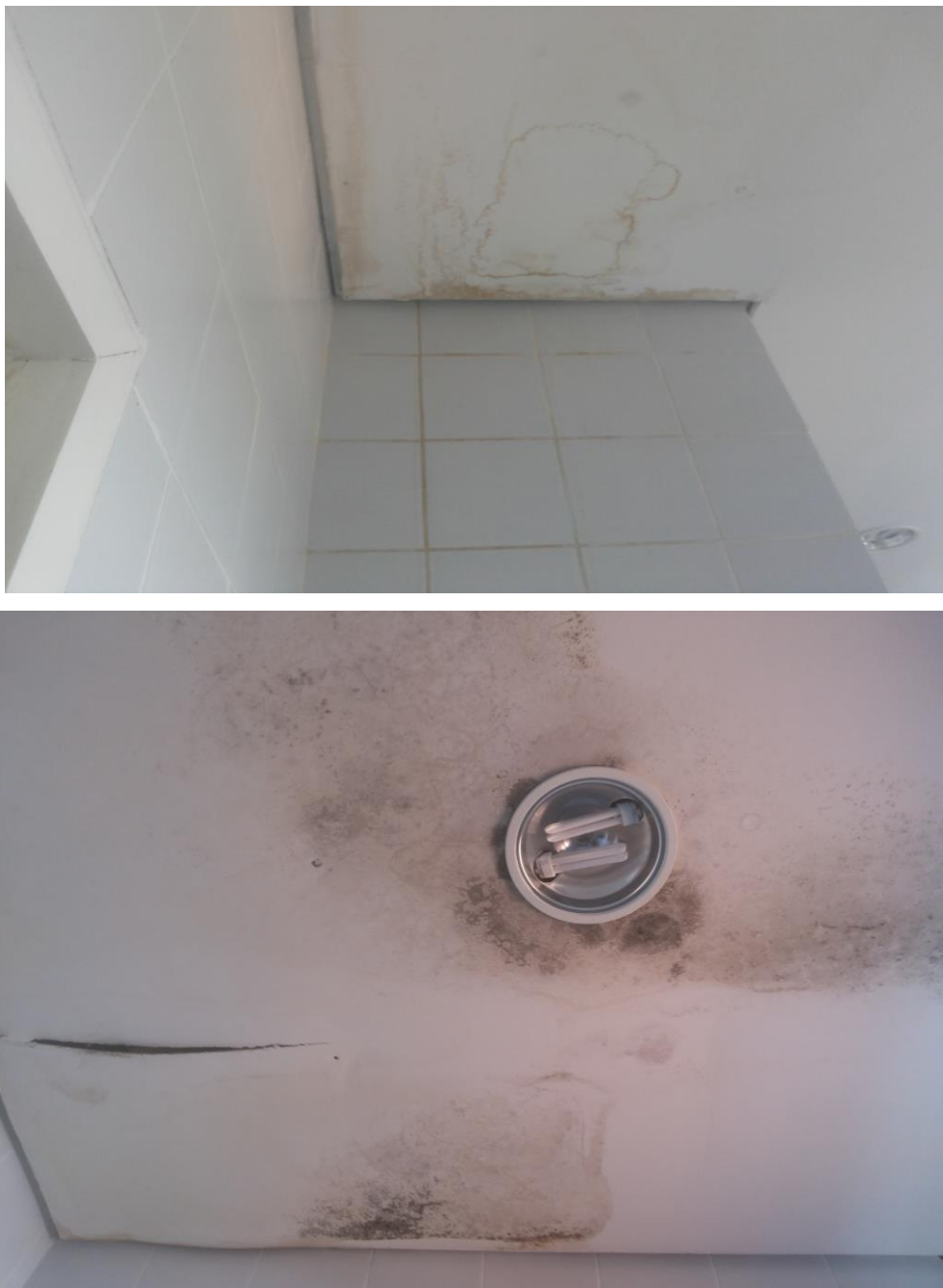
Figura 10 – Banheiro feminino pavimento superior.
