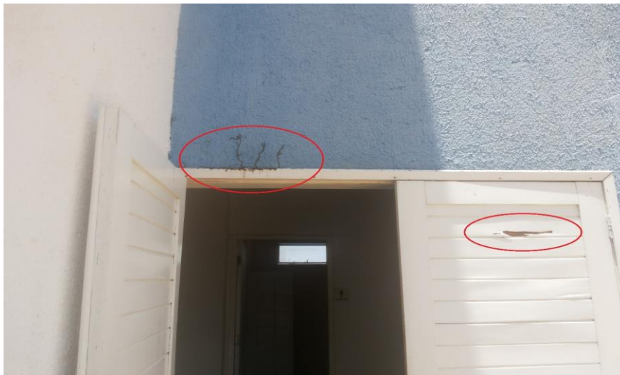
Figura 23 – Porta Lateral de Saída de Emergência do LAB-QFM.
