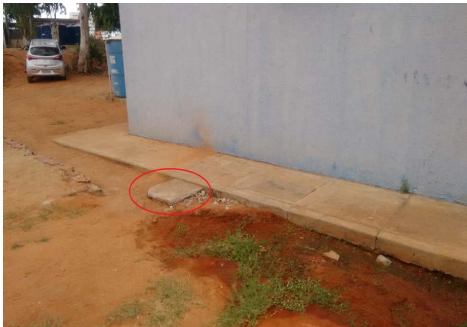
Figura 18 – Caixa de Fecho do Registro.
