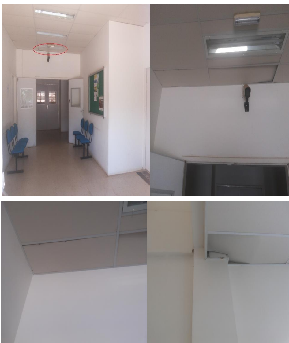
Figura 8 - Hall de entrada do LAB-QFM.
