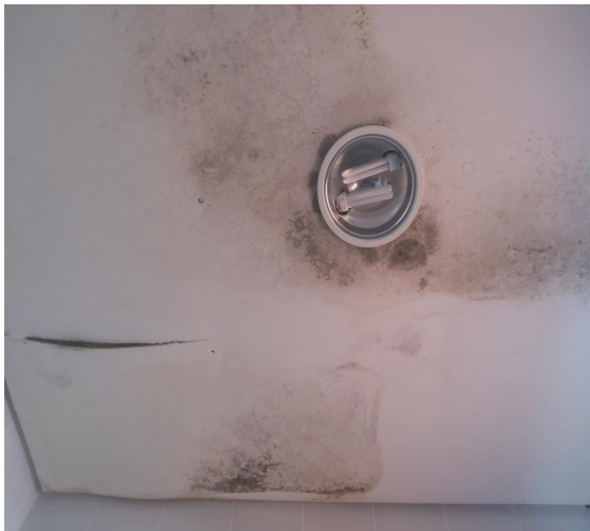
Figura 20 – Banheiro feminino do pavimento superior.
