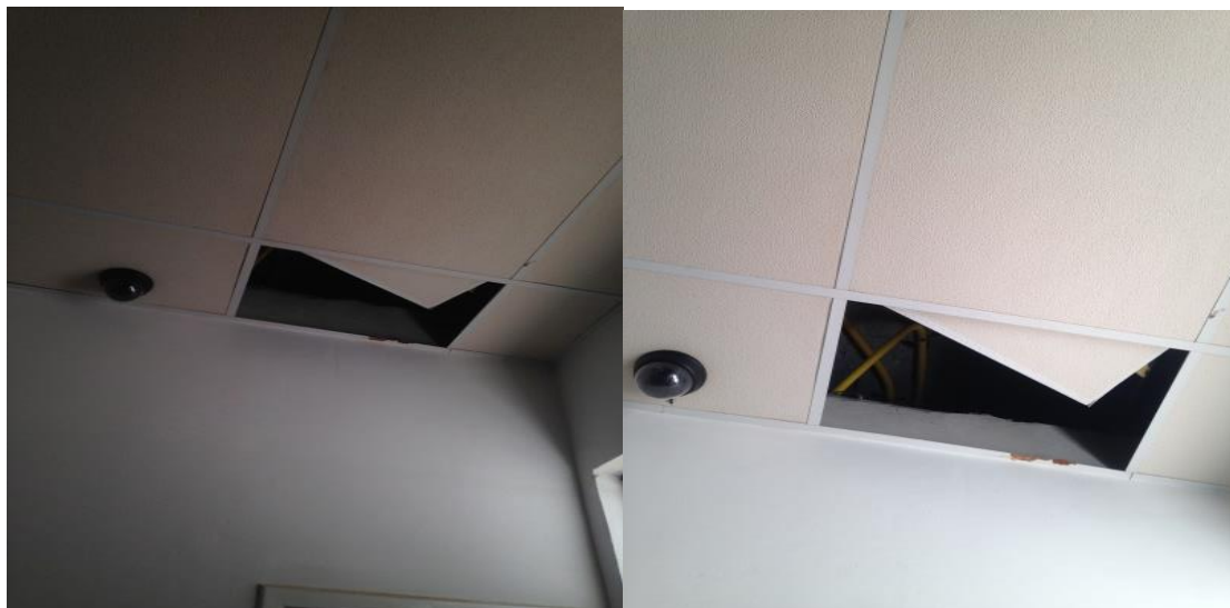
Figura 13 – Forro do Laboratório de Eletricidade e Magnetismo.
