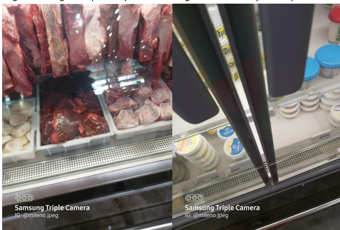
Figura 22: Fígado e portas que não conseguem uma vedação completa.
