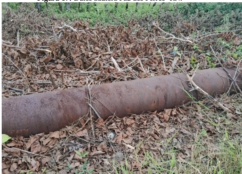
Figura 17: Dutos adutora Pau dos Ferros -RN.
