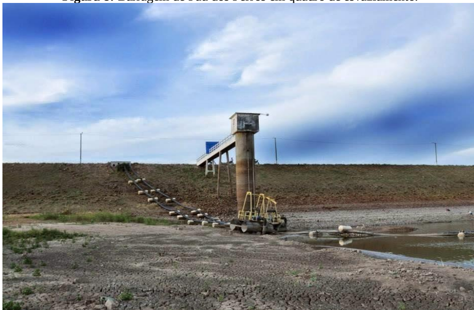
Figura 8: Barragem de Pau dos Ferros em quadro de esvaziamento.
