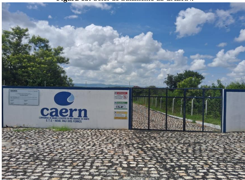
Figura 13: Setor de tratamento da CAERN.
