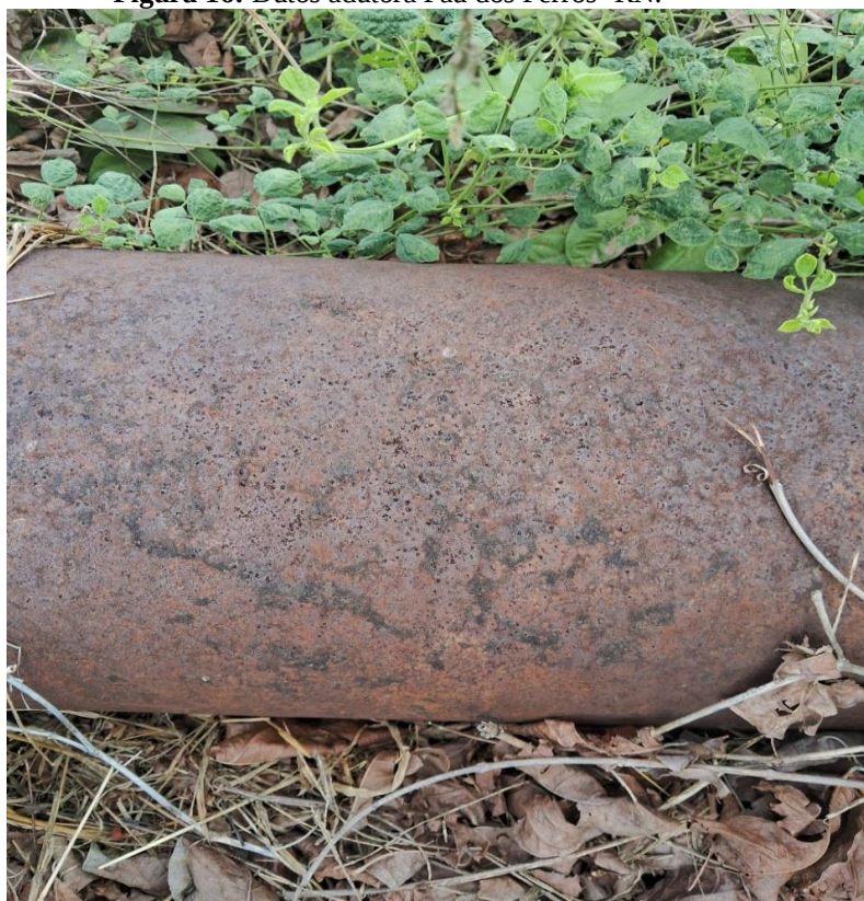
Figura 16: Dutos adutora Pau dos Ferros -RN.
