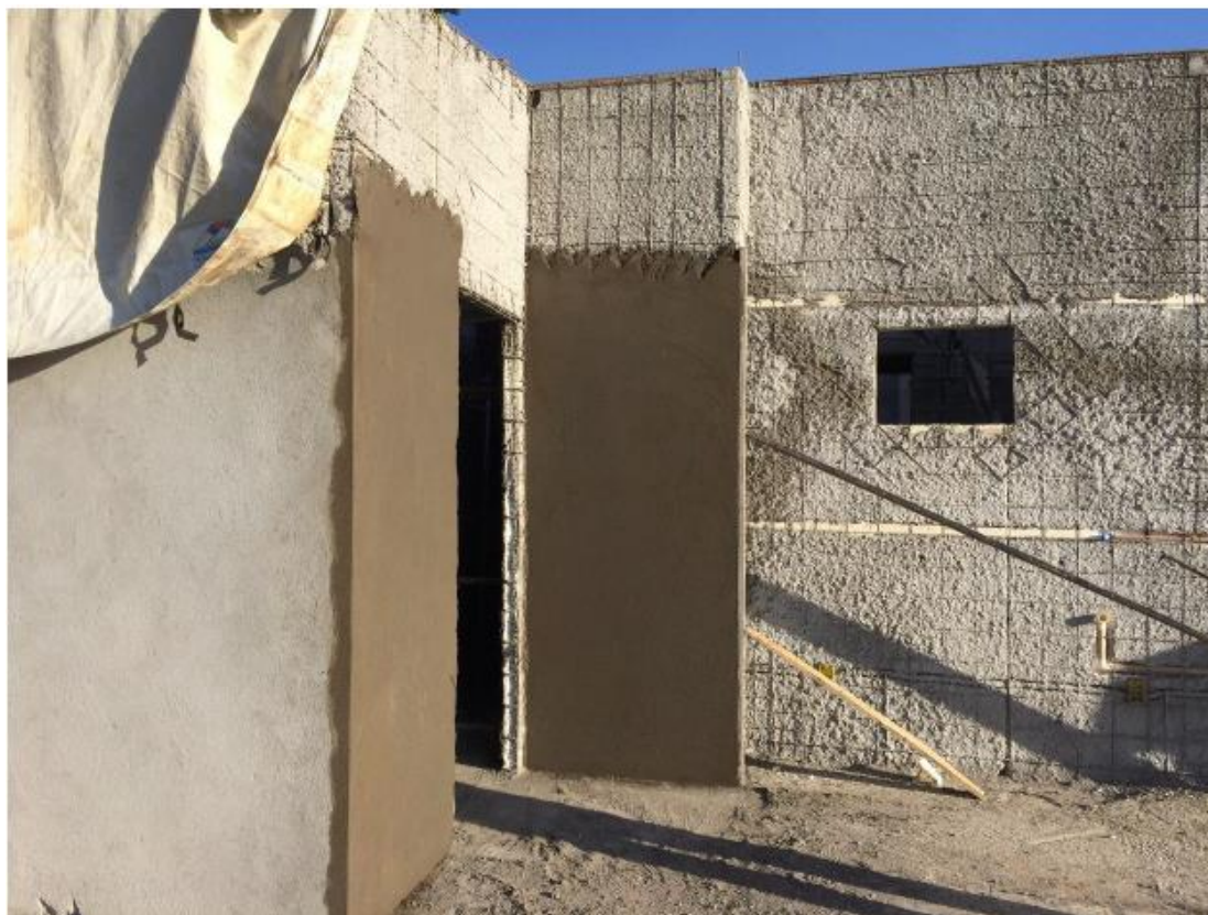
Figura 25(b): Segunda camada de revestimento
