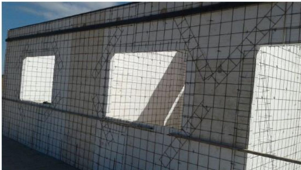
Figura 23: Reforços aplicados nos cantos de portas e janelas
