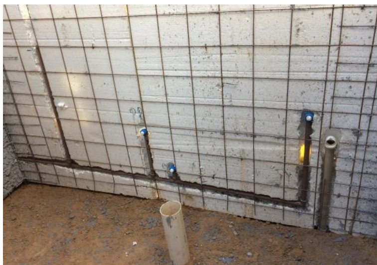
Figura 16: Instalações hidrossanitárias nos painéis
