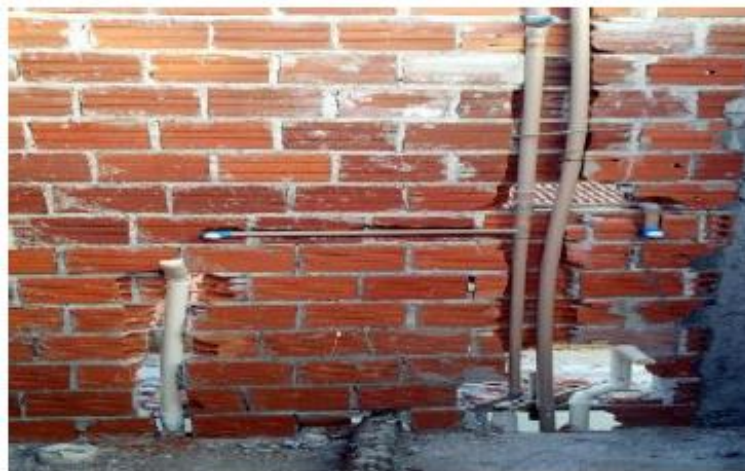
Figura 05: Instalação hidráulica
