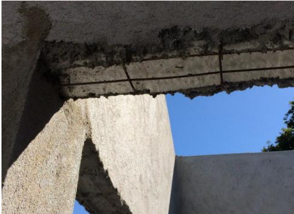
Figura 12: Aplicação de reforço do tipo U
