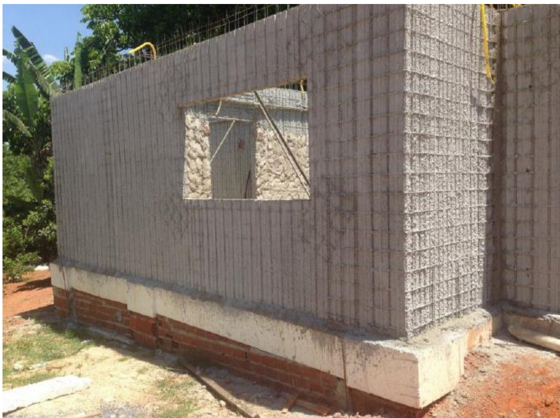
Figura 25(a): Primeira camada de revestimento
