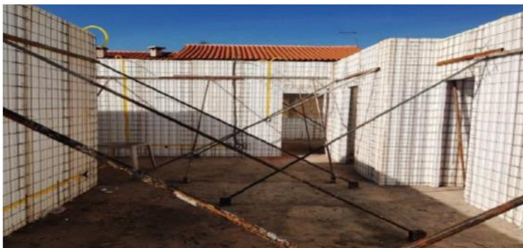
Figura 24: Réguas e escoras em obra
