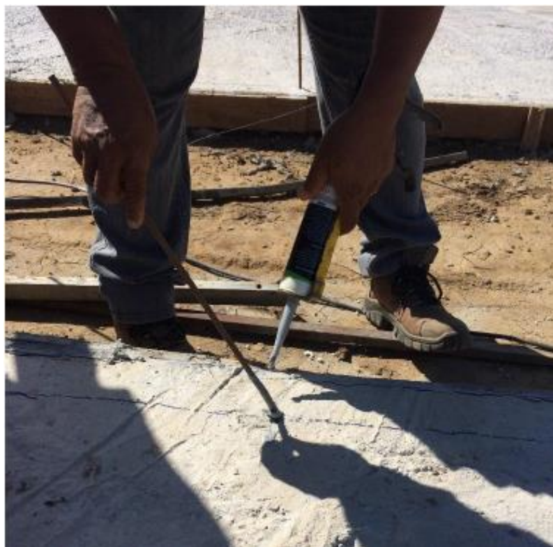
Figura 13: Fixação dos arranques
