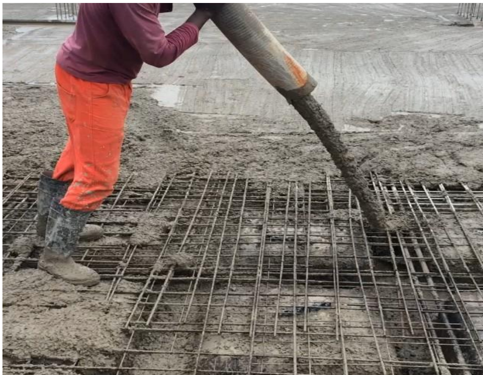
Figura 3– Concretagem de Laje.
