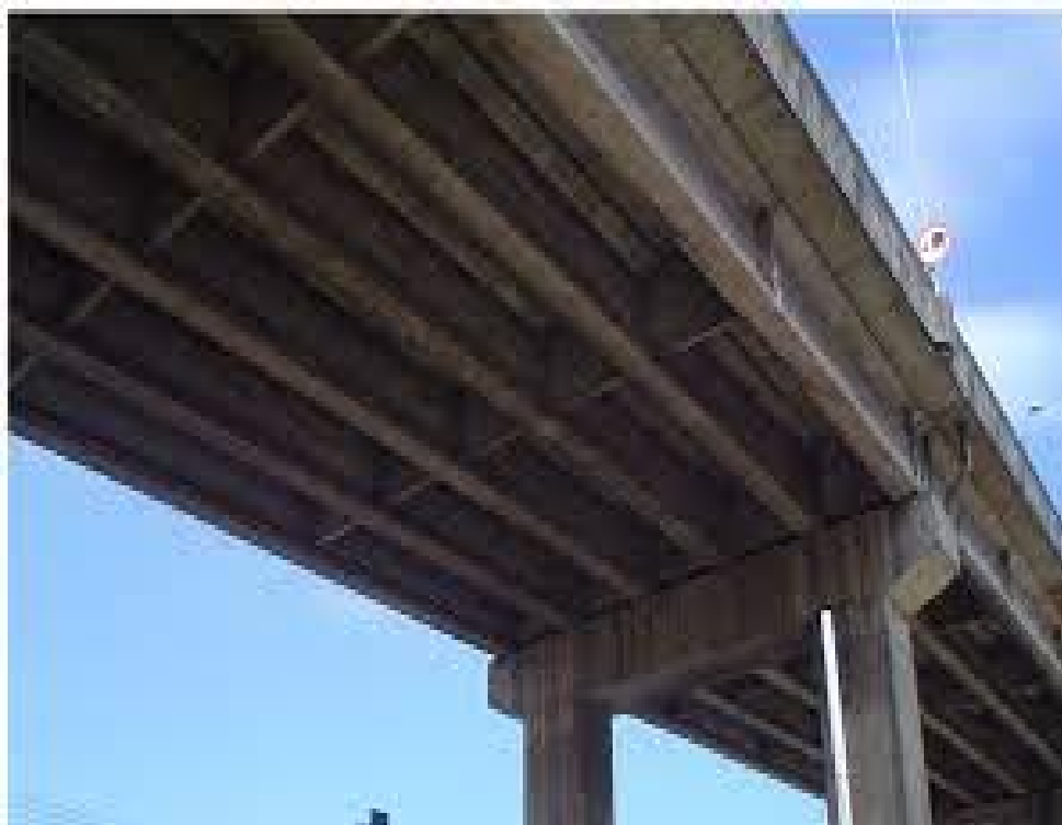
Figura 9– Viga T em Ponte.
