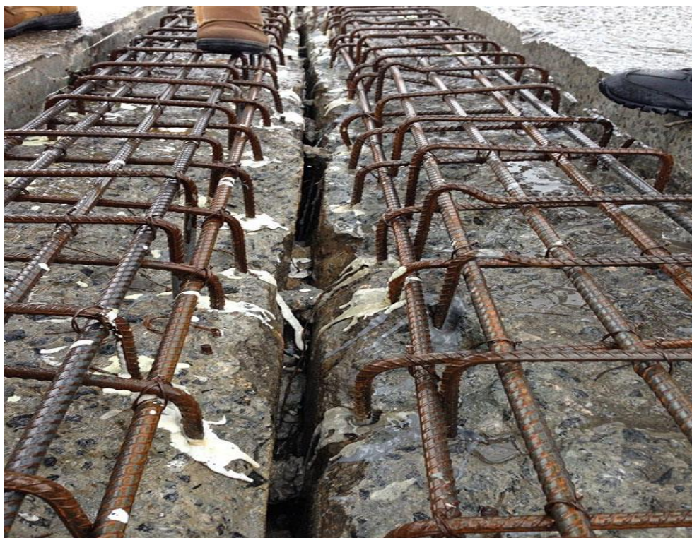
Figura 1–Estrutura em concreto armado.
