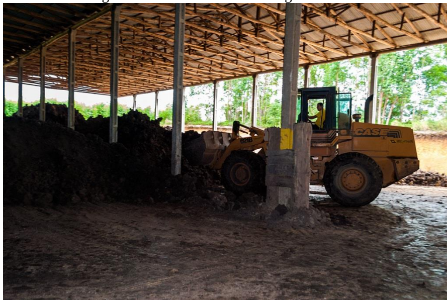
Figura 09: Armazenamento da argila
