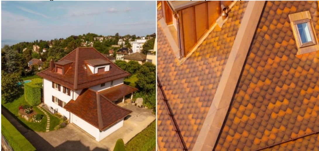
Figura 14 – Telhas solares com coloração por filme polimérico
