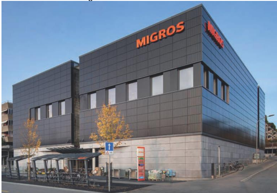
Figura 9 – Fachada solar BIPV
