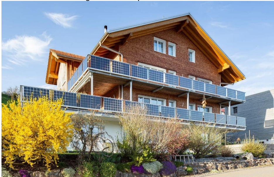
Figura 8 – Parapeito solar BIPV
