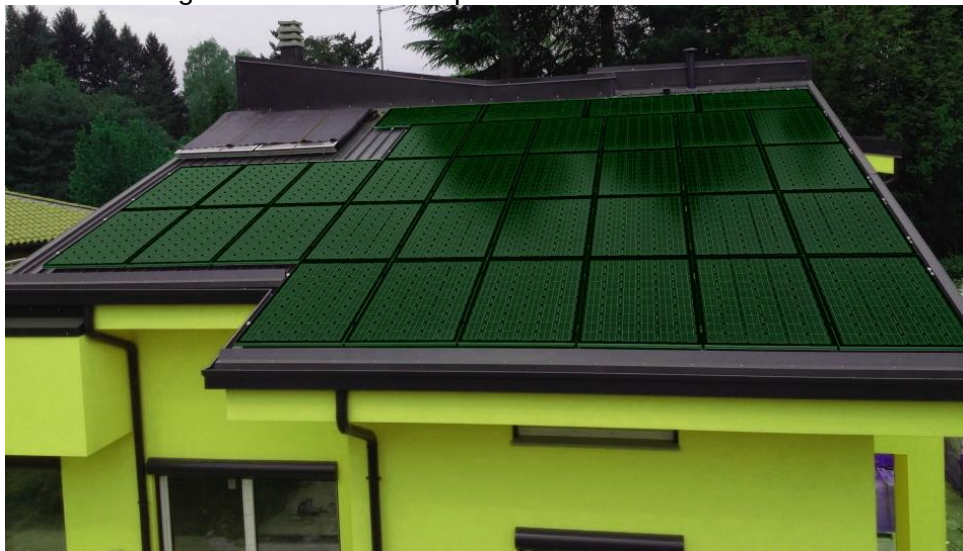
Figura 13 – Cor obtida por vidro colorido em massa
