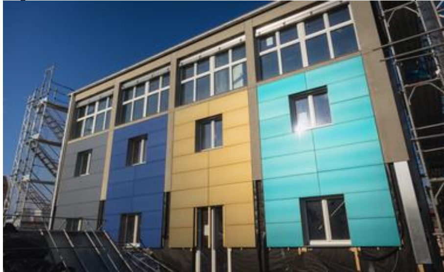
Figura 20 – Painéis solares com revestimento de interferência óptica
