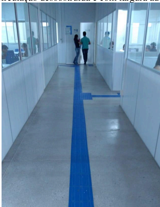
Figura 31 - Circulação desobstruída e com largura adequada
