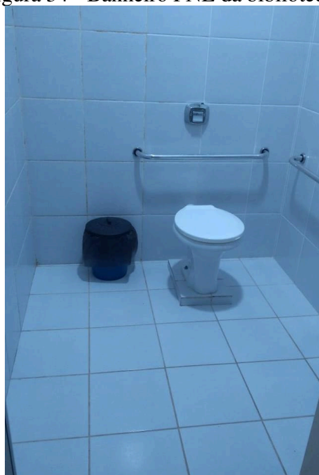
Figura 34 - Banheiro PNE da biblioteca
