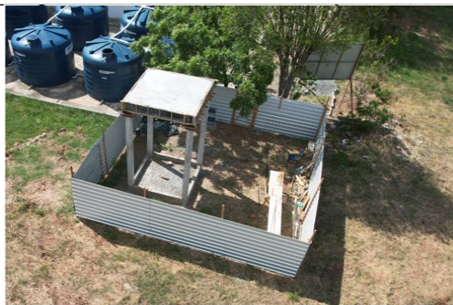
Figura 7. Imagem de drone de laje concretada do reservatório DITRANS. Fonte: Autoria própria (2025).
