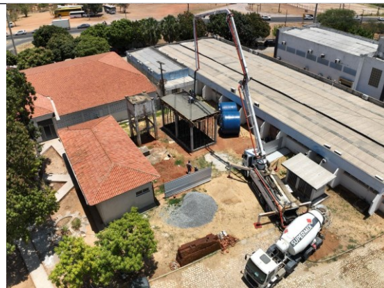
Figura 14. Imagem feita por drone do canteiro de obras do LASAP. Fonte: Autoria própria (2025).
