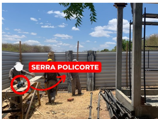
Figura 18. Imagem feita por câmera celular de canteiro de obra do DITRANS. Fonte: Autoria própria (2025).
