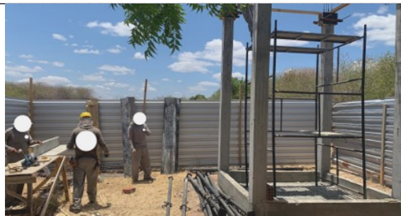
Figura 2. Caixotes para concretagem de reservatório DITRANS. Fonte: Autoria própria (2025).
