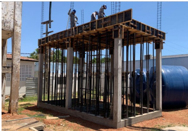
Figura 13. Imagem feita por câmera celular da concretagem da laje do LASAP. Fonte: Autoria própria (2025).
