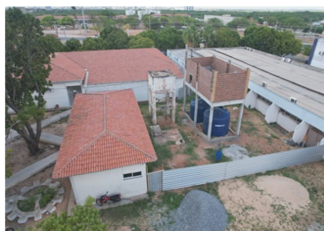
Figura 6. Imagem de drone da alvenaria do reservatório LASAP. Fonte: Autoria própria (2025).
