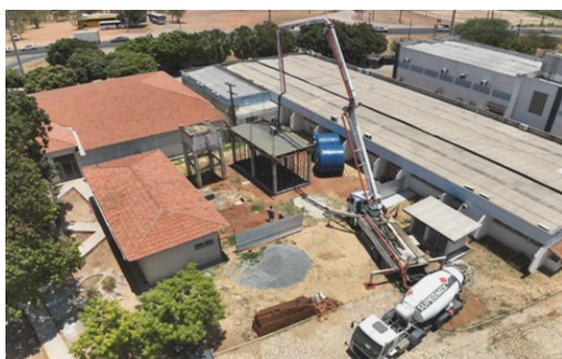
Figura 5. Imagem de drone da concretagem de laje do reservatório LASAP. Fonte: Autoria própria (2025).
