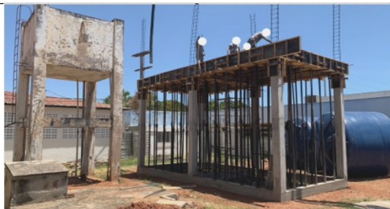
Figura 1. Concretagem de laje de reservatório LASAP. Fonte: Autoria própria (2025).
