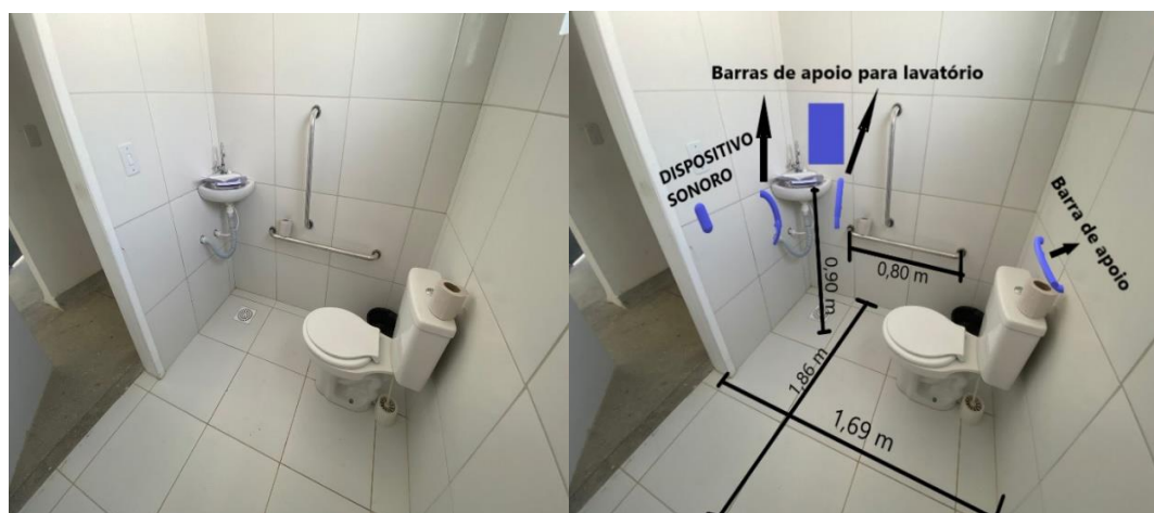
Figura 25 – Antes e depois Banheiro exigido de acordo com a norma 9050/2020
