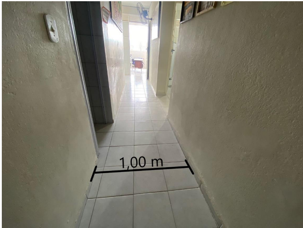
Figura 17 - Dimensão do corredor da unidade
