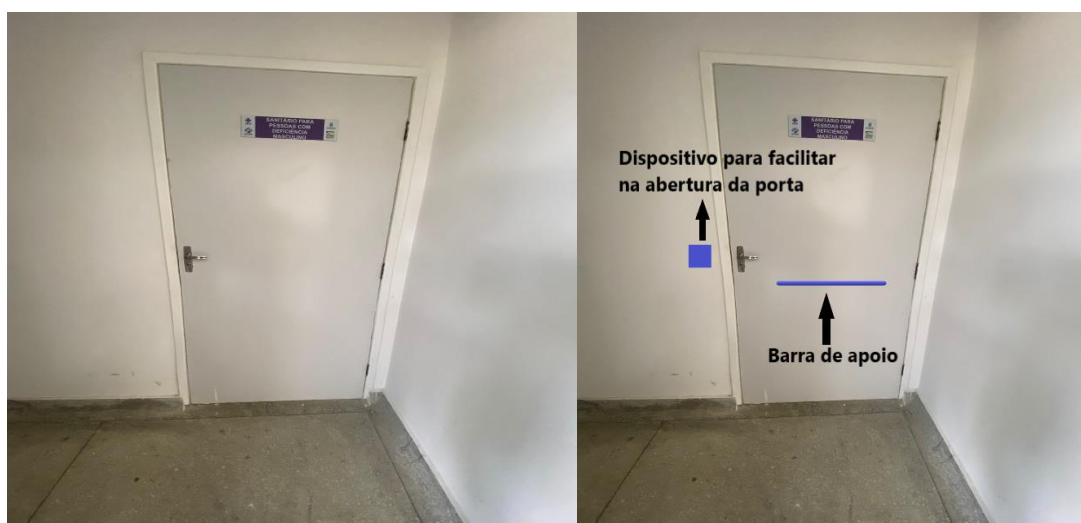
Figura 24 - Antes e depois da porta incluindo a barra de apoio
