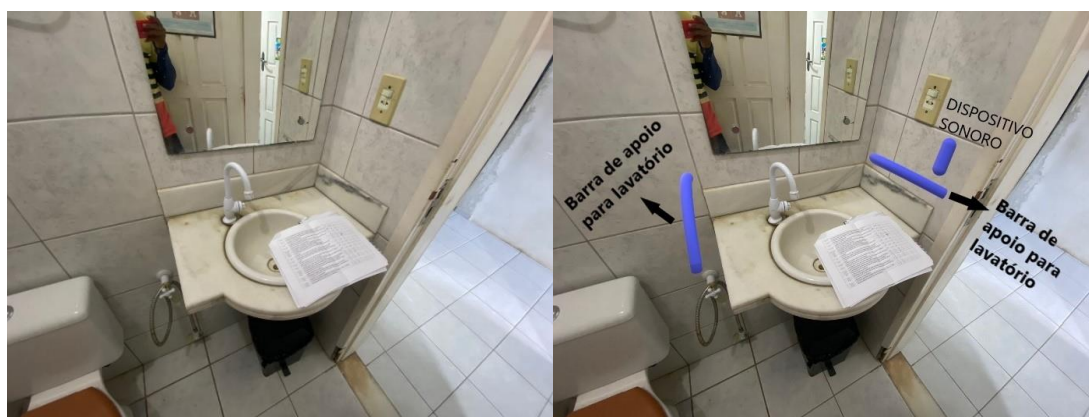
Figura 19 - Antes e depois de um lavatório acessível
