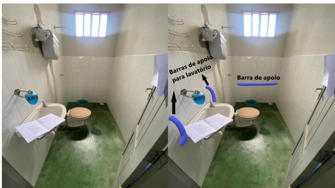
Figura 13 - Antes e depois da colocação de barras de apoio ao longo do banheiro
