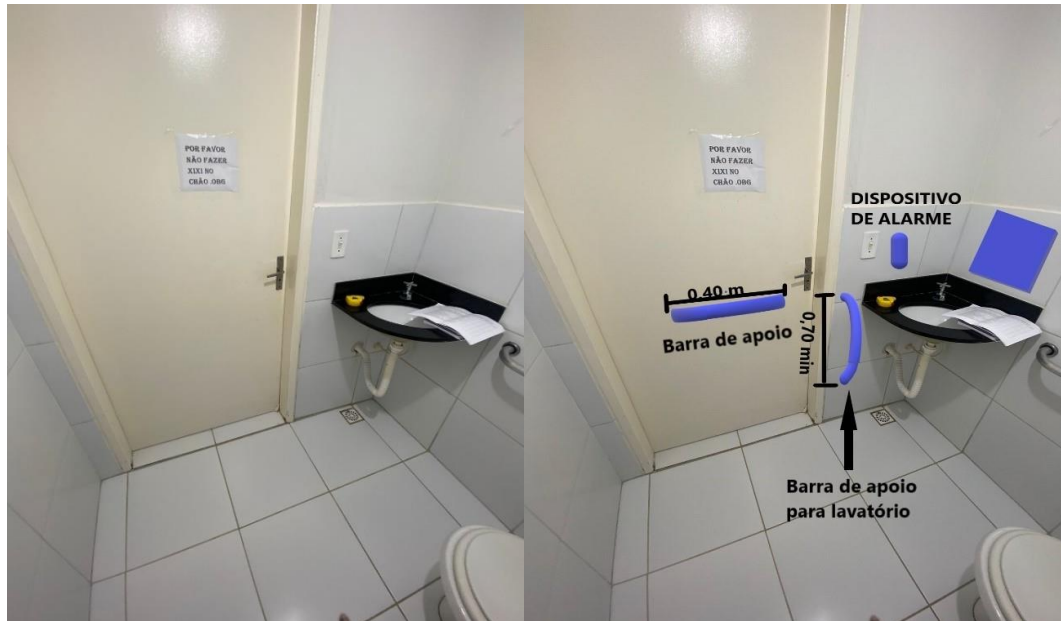
Figura 5 - Antes e depois do banheiro conforme a norma 9050/2020
