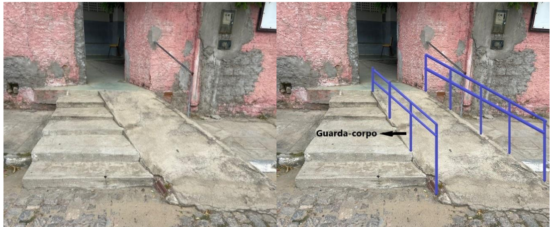
Figura 9 - Antes e depois da rampa de acesso para a unidade básica de saúde
