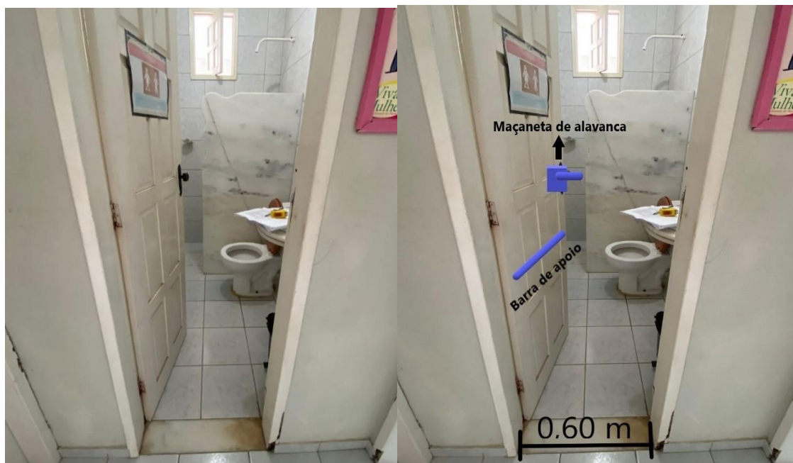
Figura 18 - Antes e depois de porta do banheiro como define a norma 9050/2020
