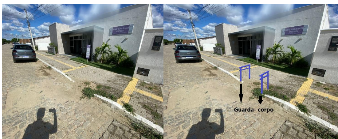
Figura 22 - Antes e depois da rampa conforme a norma 9050/2020
