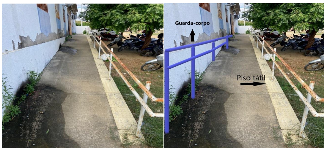
Figura 4 - Antes e depois conforme a norma 9050/2020
