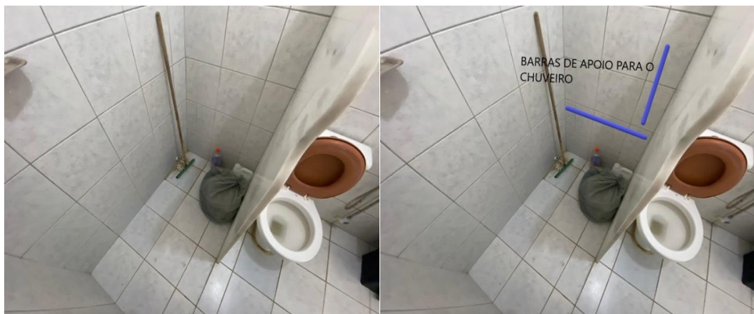
Figura 20 - Antes e depois do box conforme a norma 9050/2020
