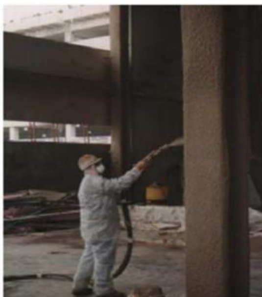
Figura 11– Aplicação de argamassa projetada.
