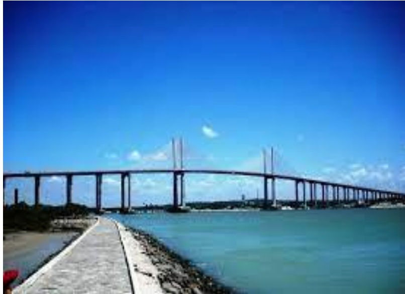
Figura 1 – Ponte sobre água
