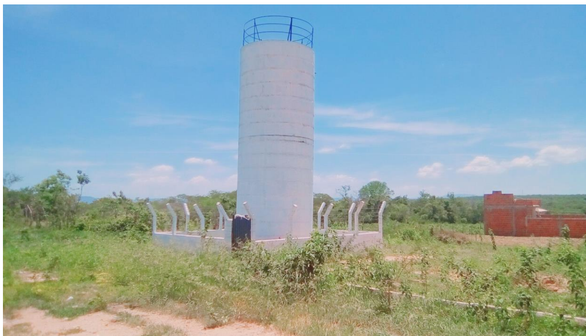
Figura 08 - Reservatório de água.
