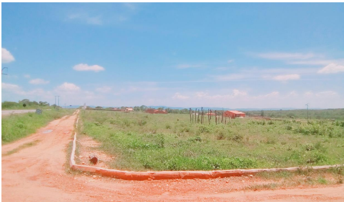
Figura 05 - Construção das casas.
