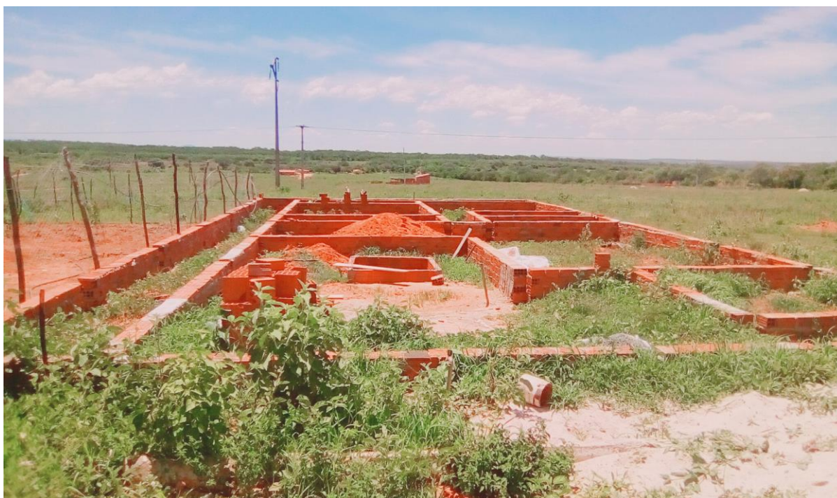
Figura 07 - Casa em processo de construção.
