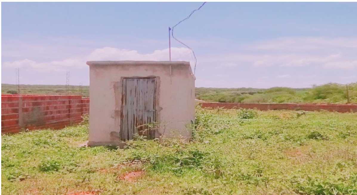
Figura 09 - Poço de onde a água é captada
