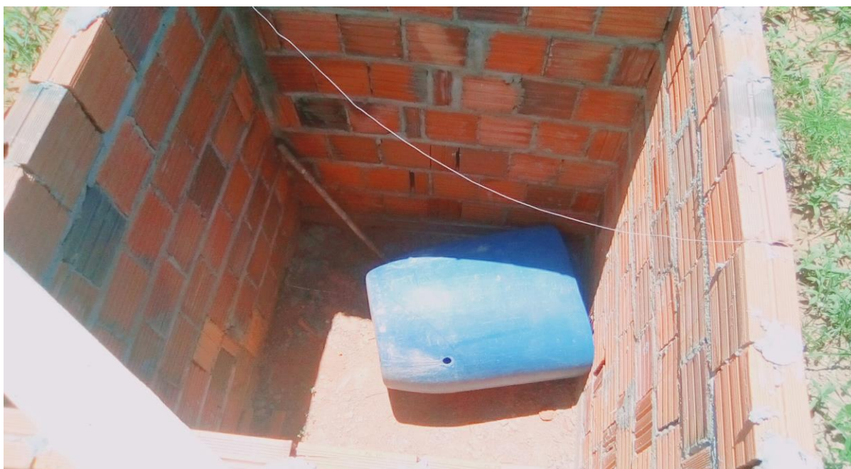
Figura 12 - Fossa rudimentar em processo de construção.
