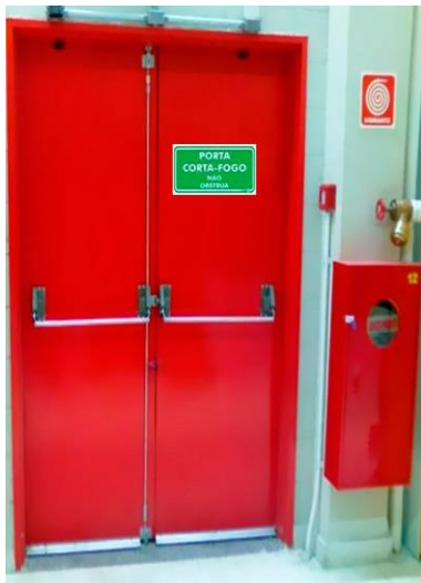
1.a) Porta de emergência
