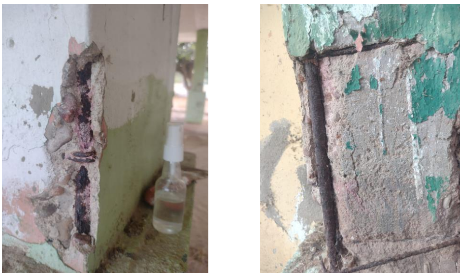
Figuras 15 e 16. Áreas analisadas com a fenolftaleína.
