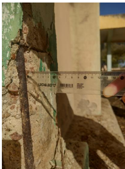
Figura 17. Espessura da área afetada.
