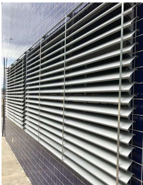
Figura 9 - Brises verticais em fachadas
