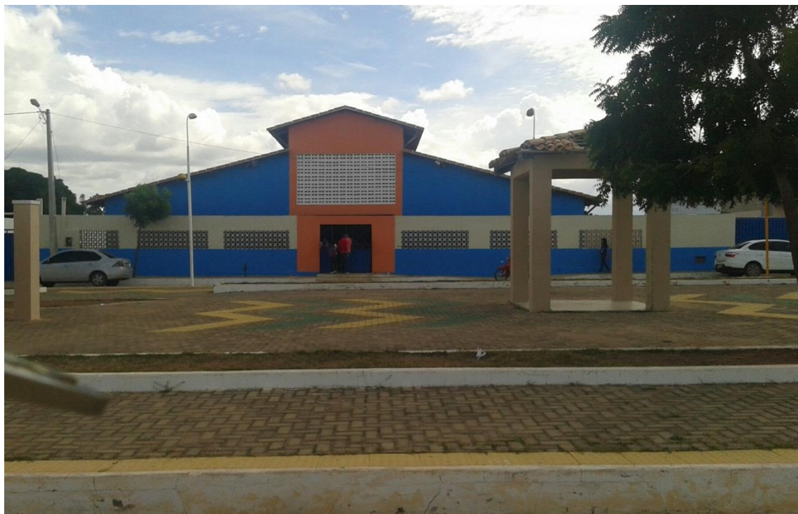
Figura 1: Imagem da fachada da Escola Municipal Vila Rio Grande do Norte.
