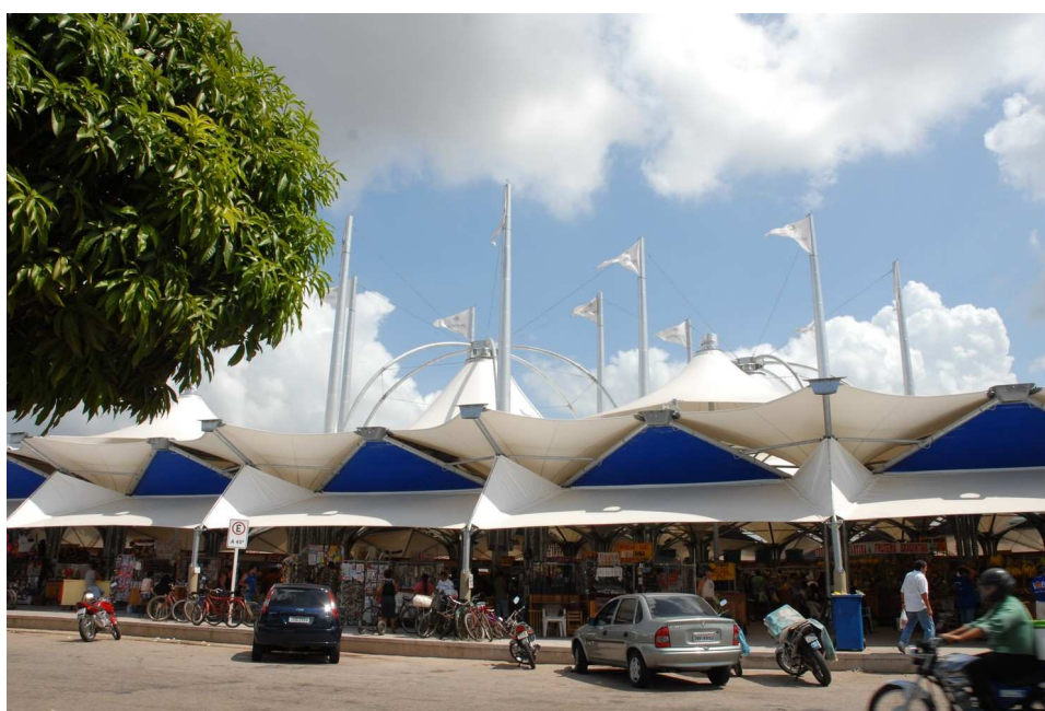
Figura 20 - Vista da Feira da Cidade ao nível dos olhos
