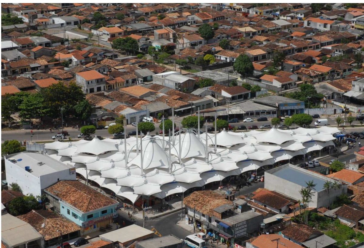
Figura 16 - Vista Aérea da Feira da Cidade
