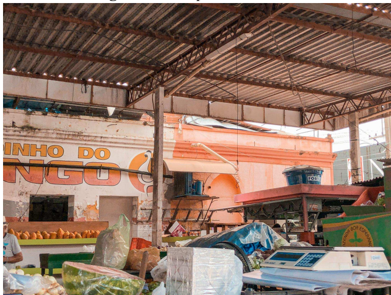
Figura 48 - Galpão das Verduras
