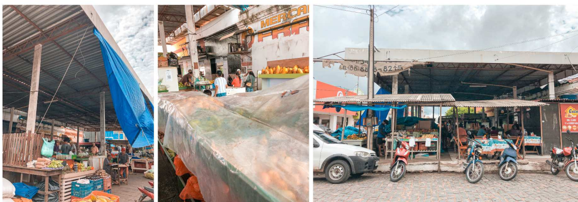
Figura 47 - Galpão das Verduras
