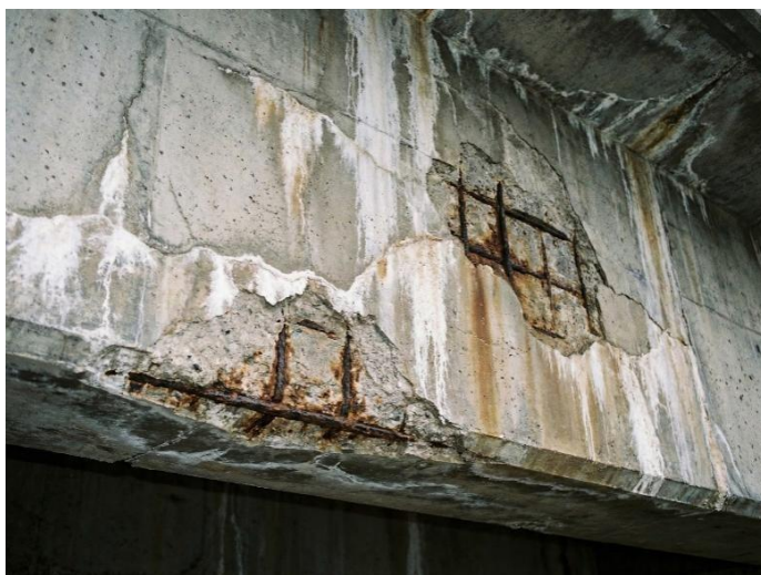
Figura 7- Imagem realista da corrosão por carbonatação
