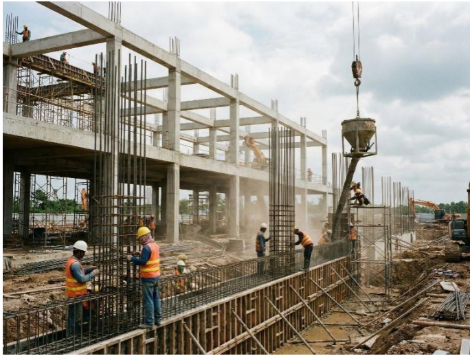
Figura 4- Imagem realista da estrutura de concreto armado sendo montada
