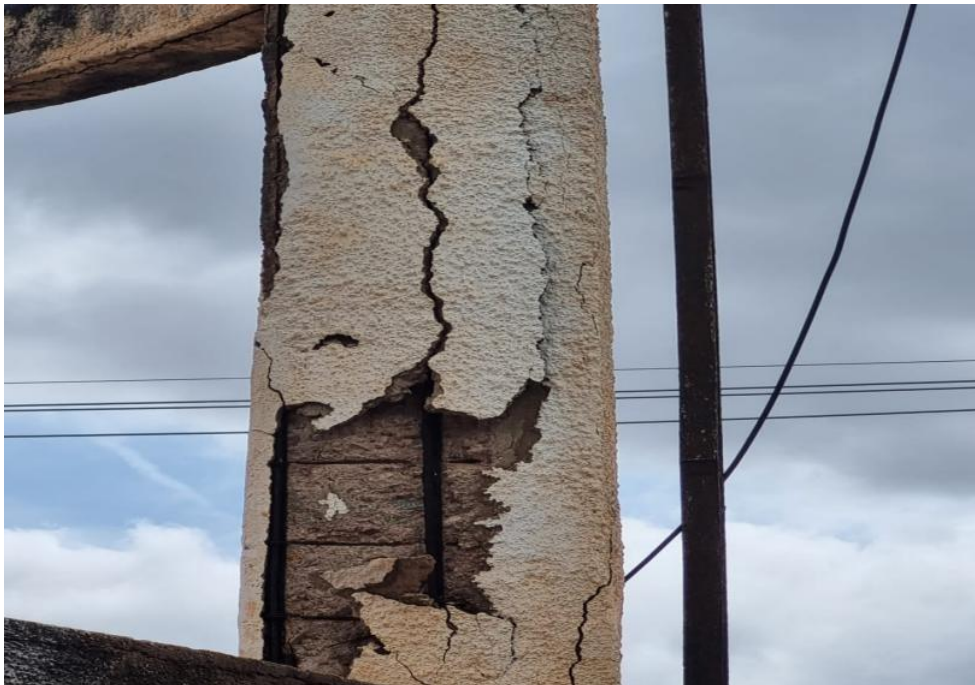
Figura 13- Registro fotográfico do pilar vertical
