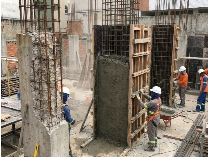
Figura 9- Ilustração do encamisamento em pilares de concreto armado
