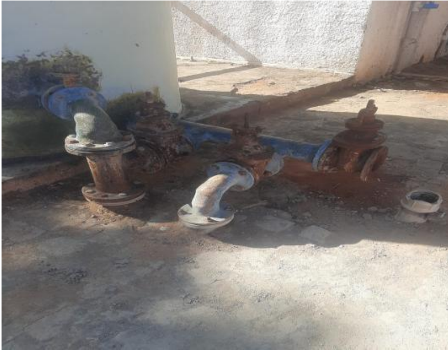
Figura 14- Registro fotográfico das tubulações e das válvulas
