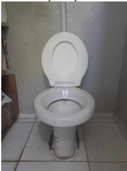
Figura 11: Expurgo de resíduos líquidos provenientes de exames laboratoriais
