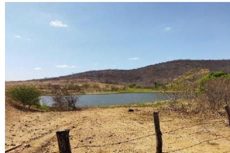
Figura 11 - Açude na zona rural em Saco da Barra
