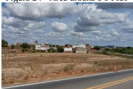
Figura 24 - Área urbana e o PISF
