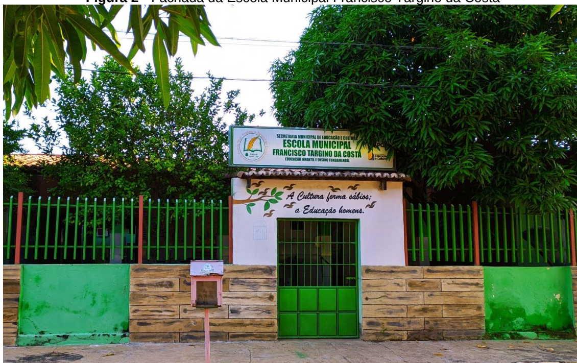
Figura 2 - Fachada da Escola Municipal Francisco Targino da Costa
