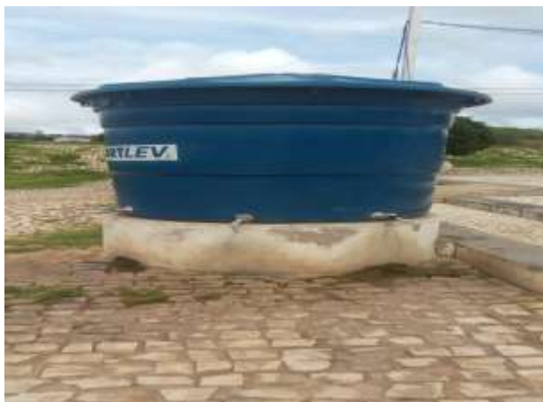
Figura 15: Reservatórios pertencente ao município
