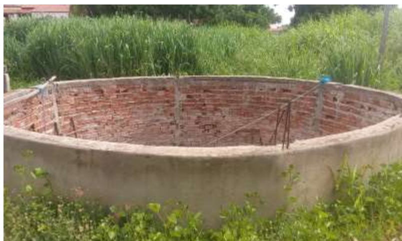
Figura 10: Cacimbão de difícil acesso
