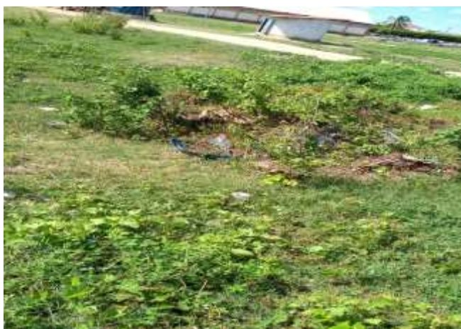
Figura 11: Lixo entulhado nas proximidades dos poços
