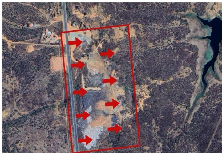
Figura 12 - Sentido do escoamento da água no lixão de Jaguaribe/CE
