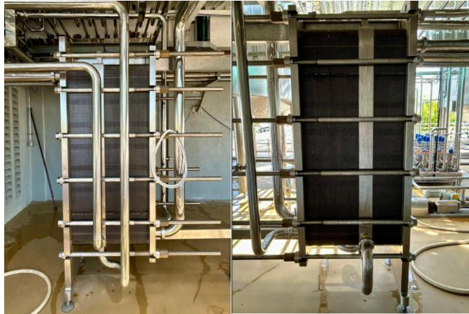
Figura 13. Trocador de calor de placas.
