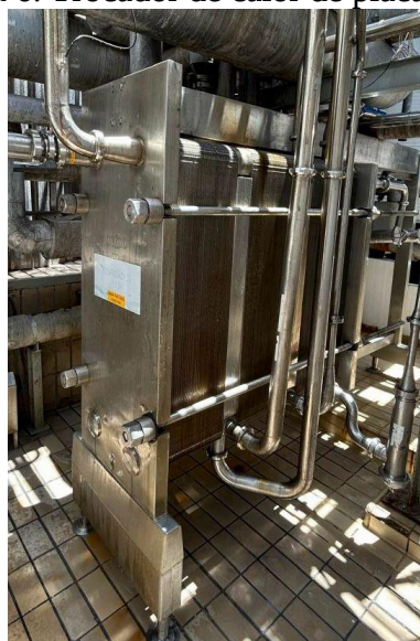
Figura 6. Trocador de calor de placas.
