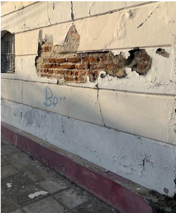
Figura 39: Deformidades na Fachada Lateral Esquerda
