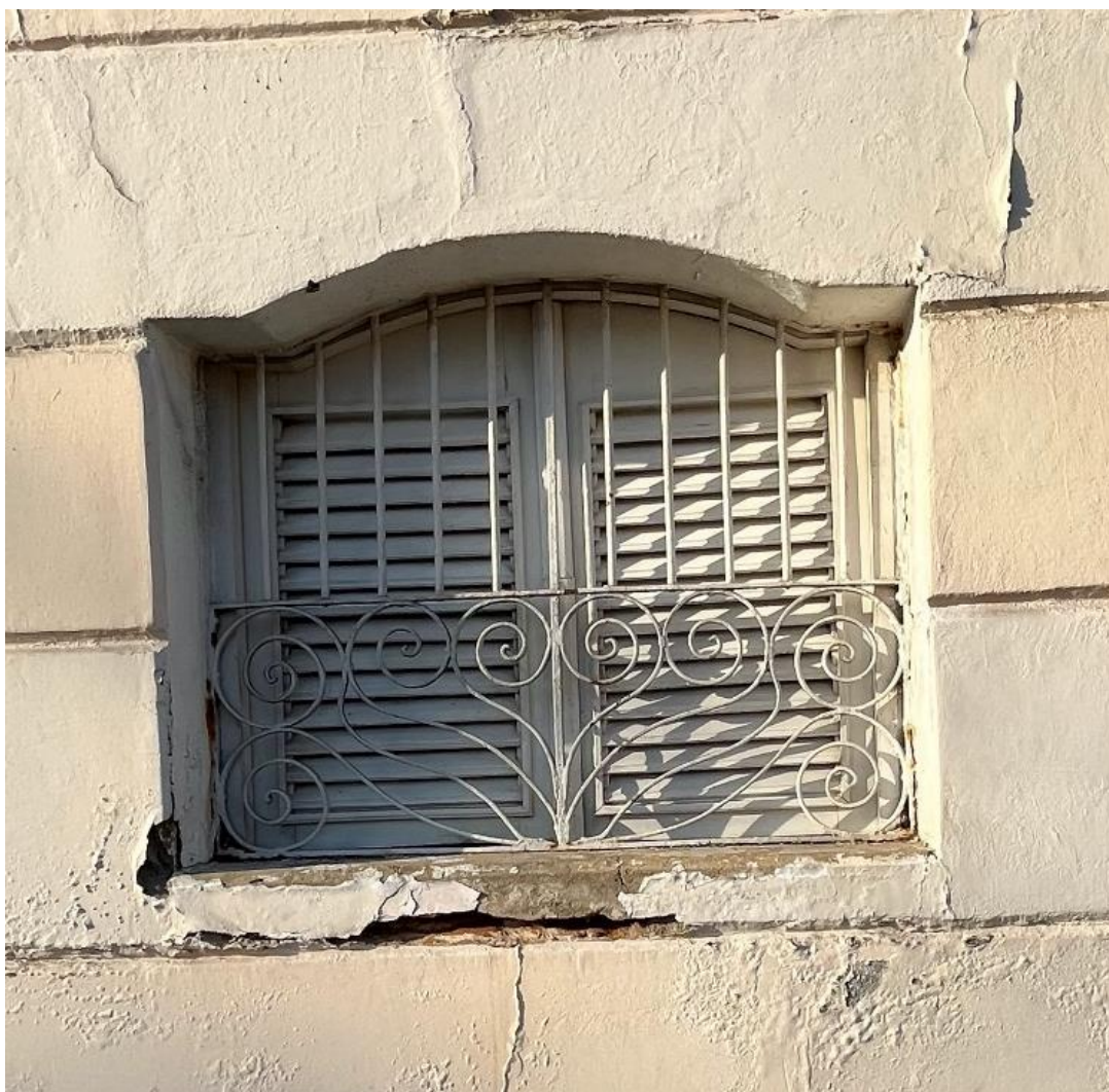
Figura 54: Esquadria Original da Edificação.
