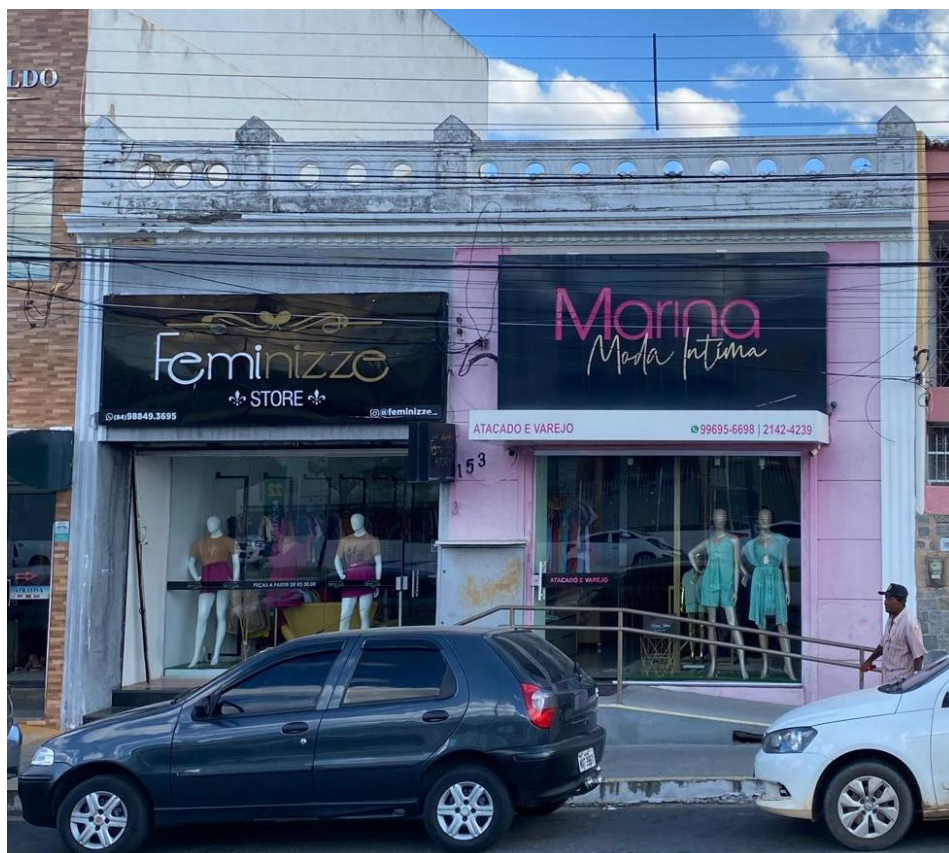
Figura 21: Fachada histórica em centro comercial de Mossoró - RN.
