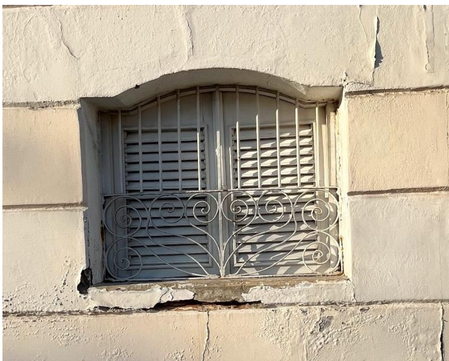
Figura 41: Janela na Fachada Lateral Esquerda
