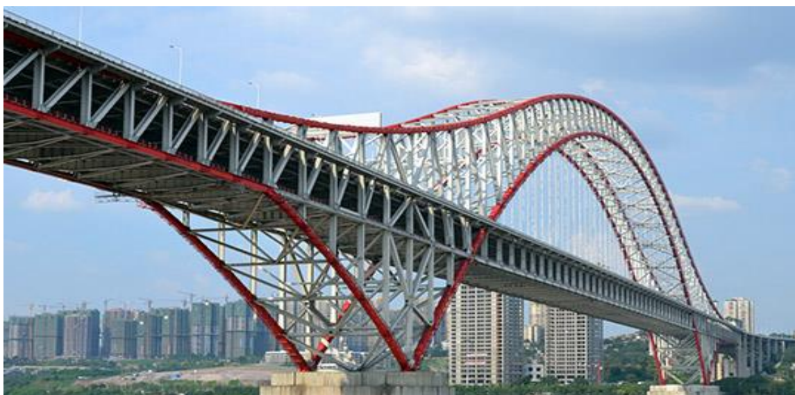
Figura 1 – Utilização das treliças na construção de uma ponte em aço.
