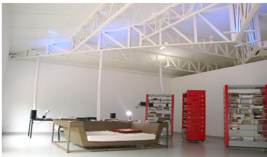
Figura 8 – Cobertura metálica treliçada.
