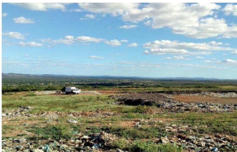
Figura 4 – Vista panorâmica do aterro municipal
