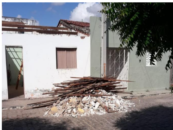
Figura 12 – Residência localizada no bairro Retiro na cidade de Uiraúna-PB.
