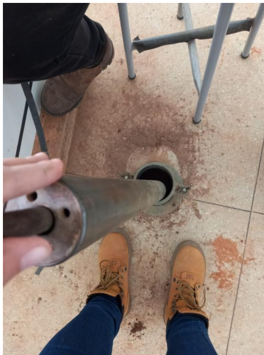
Figura 14 – Processo de compactação utilizando um soquete
