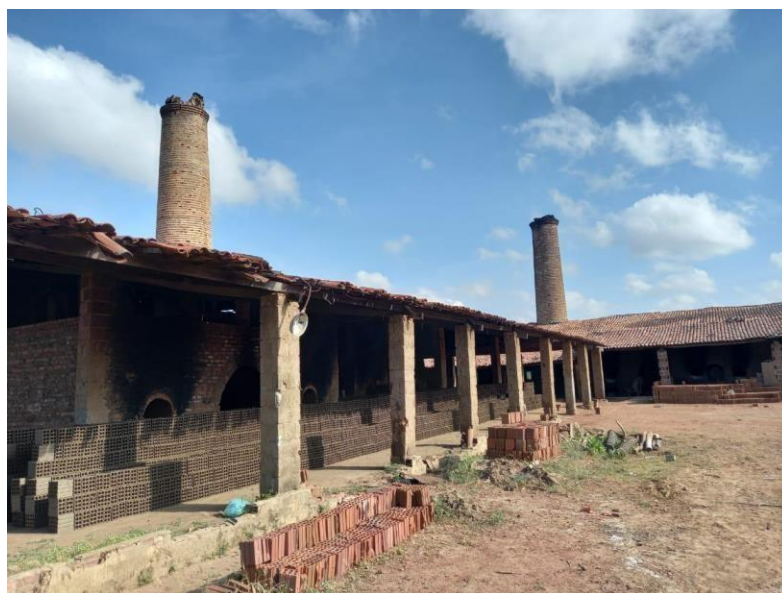
Figura 4 - Tijolos na cidade de Marcelino Vieira – RN.
