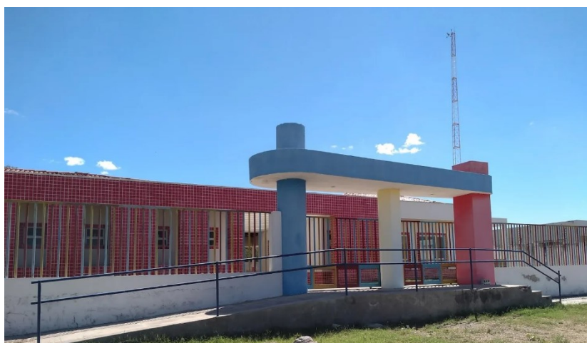
Figura 4 - Fachada da Escola
